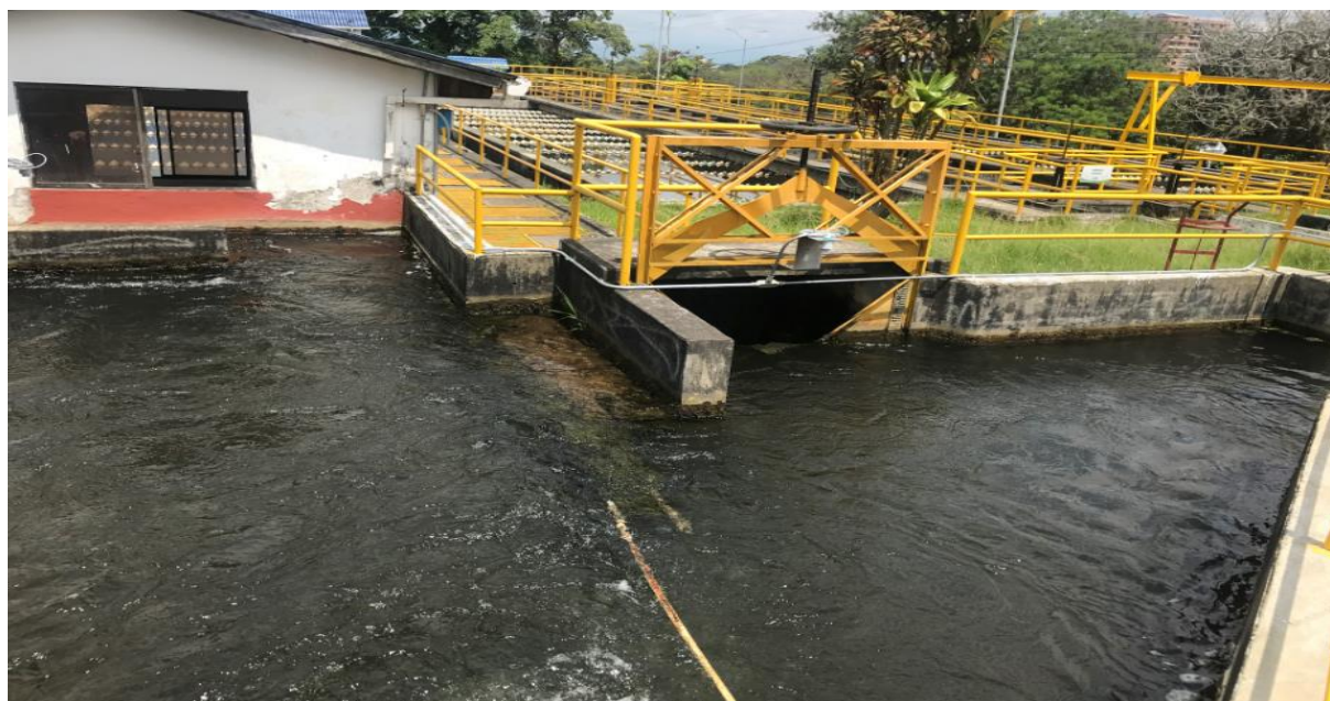
Camara de Distribución de Caudales
