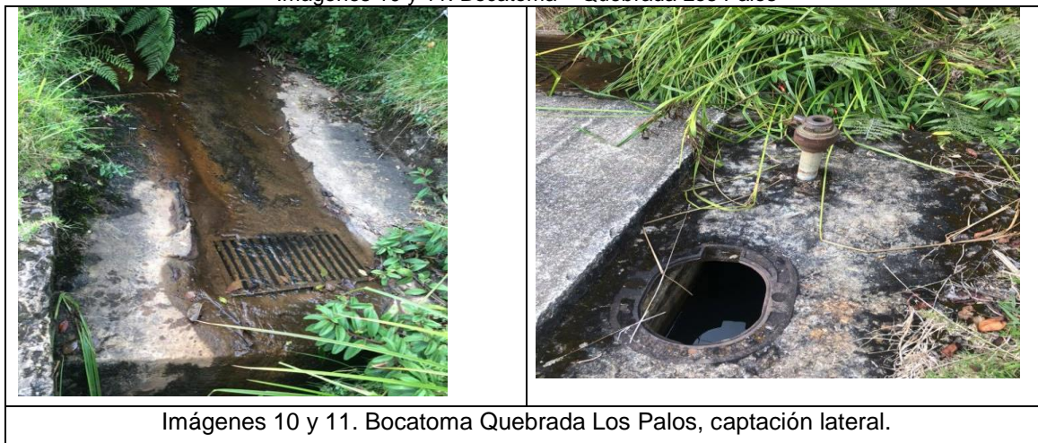
Imágenes 10 y 11. Bocatoma – Quebrada Los Palos
