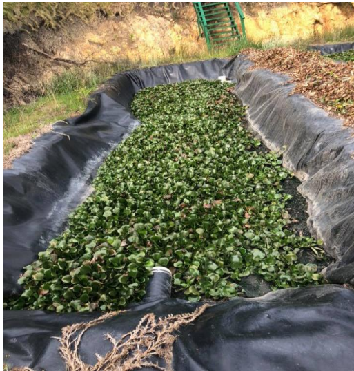
Imágenes 66 y 67. Canalización abierta de aguas servidas, tratadas con micrófitas.
