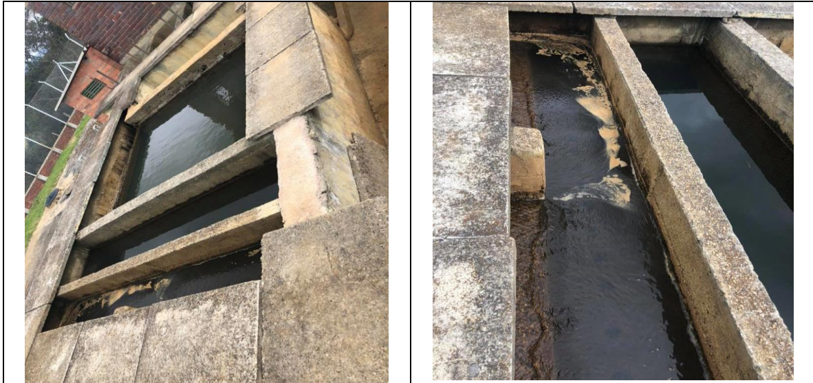
Imágenes 18 y 19. Sedimentador laminar
