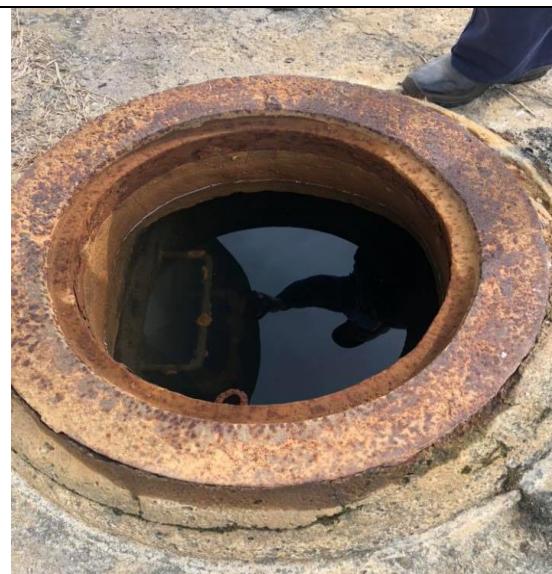
Imagen 21. Tanque de almacenamiento 60m3.
