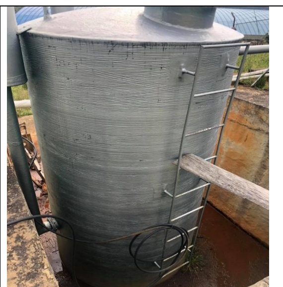
Imagen 37. Filtro de arena, antracita y grava.
