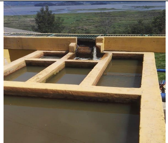
Imagen 41. Floculador de flujo vertical.
