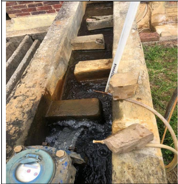
Imagen 16. Mezcla rápida, coagulación.
