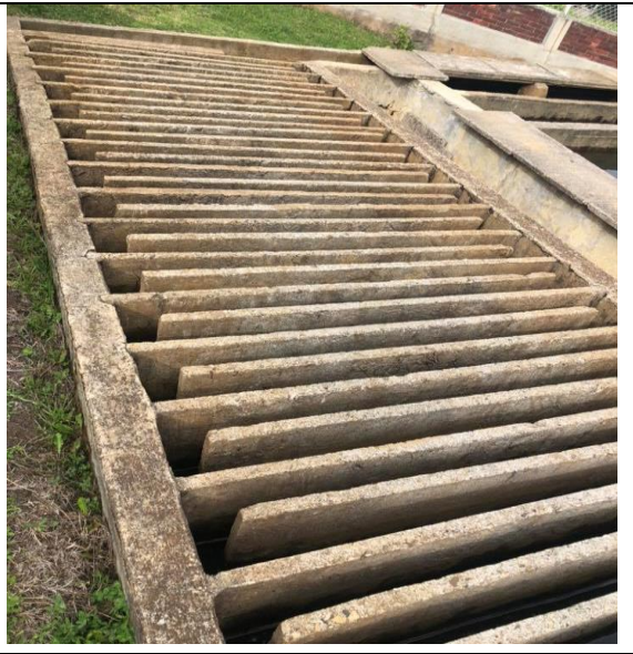
Imagen 17. Floculador de flujo horizontal, floculación.
