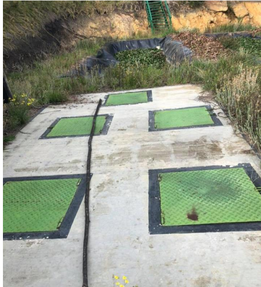
Imagen 65. Desarenador y cribado
