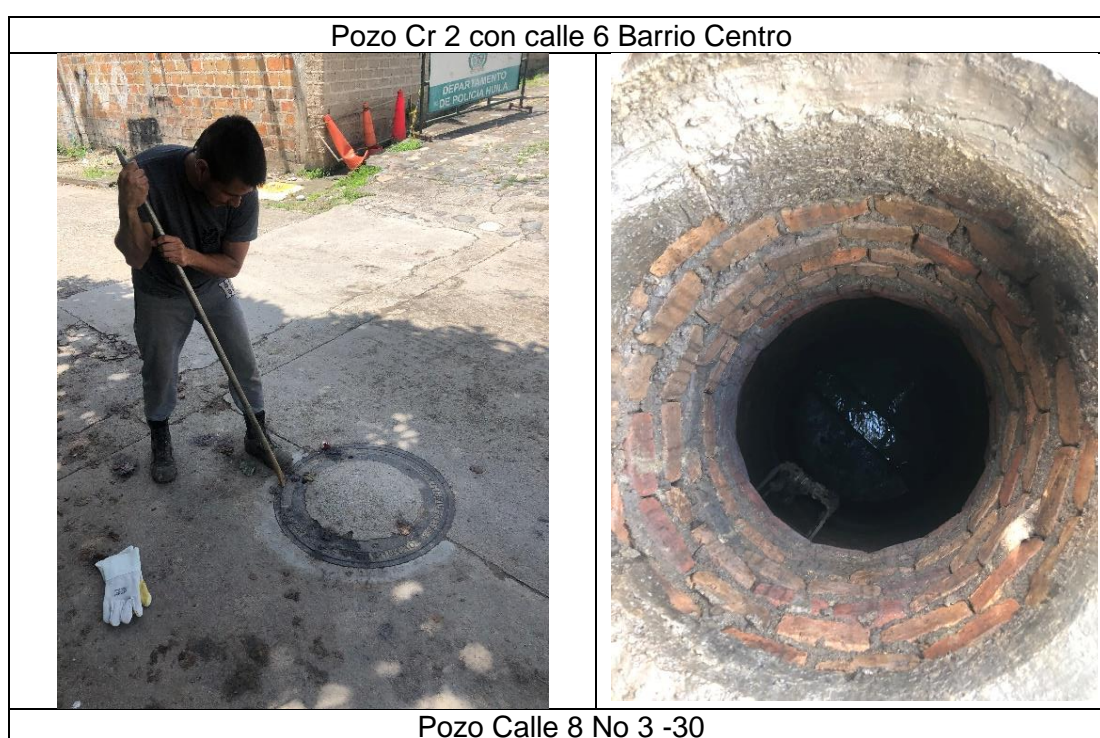
Imagen 9. Revisión pozos de inspección
