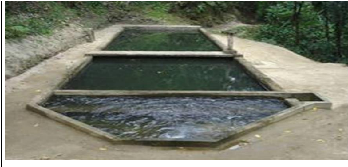
Imagen 1. Estructura desarenador
