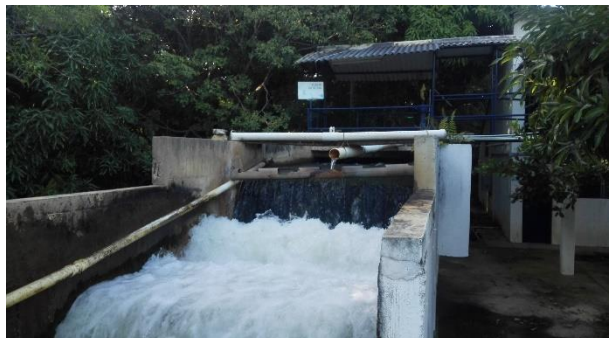
b) Mezcla rápida por resalto hidráulico
