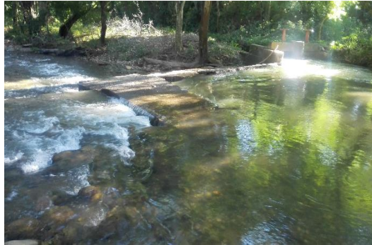
b. Desvío de excesos en aducción (Buen estado)
