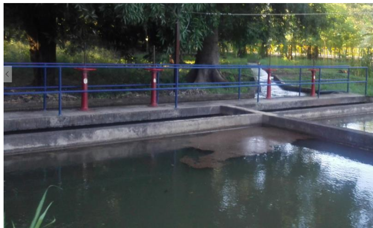
e. Entrada al desarenador
