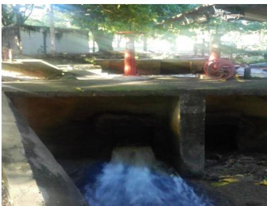
d. Compuertas para excesos en bocatoma
