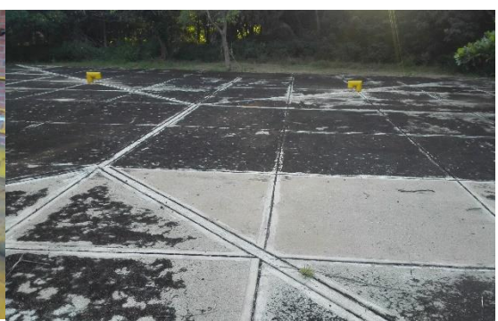
f) Tanque de compensación
