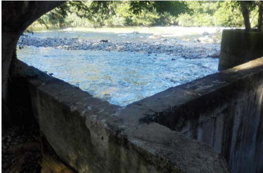
a. Captación en Río Guatapurí (Buen estado)
