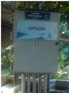
e. Dispositivo medición turbiedad, pH y conductividad en captación
