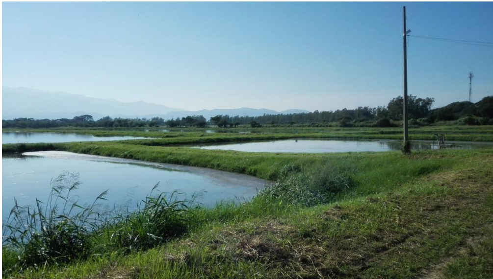
Figura 39. Sistema de Lagunas de Oxidación – STAR Salguero
