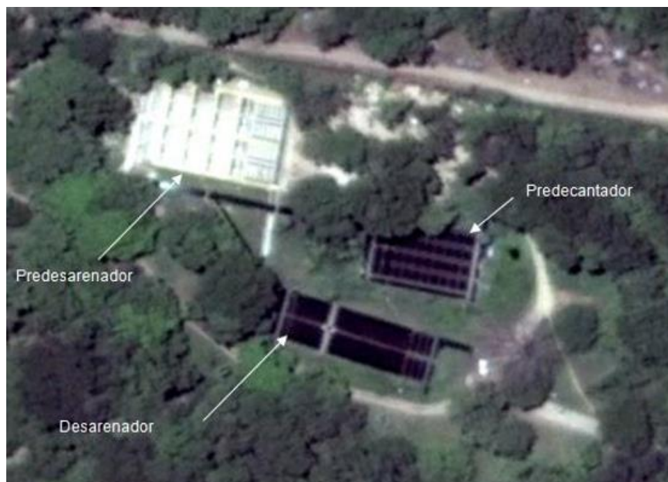
Figura 12. Sistema de Pre-Tratamiento – EMDUPAR S.A E.S.P
