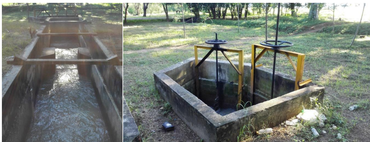
a) Canal de aforo
