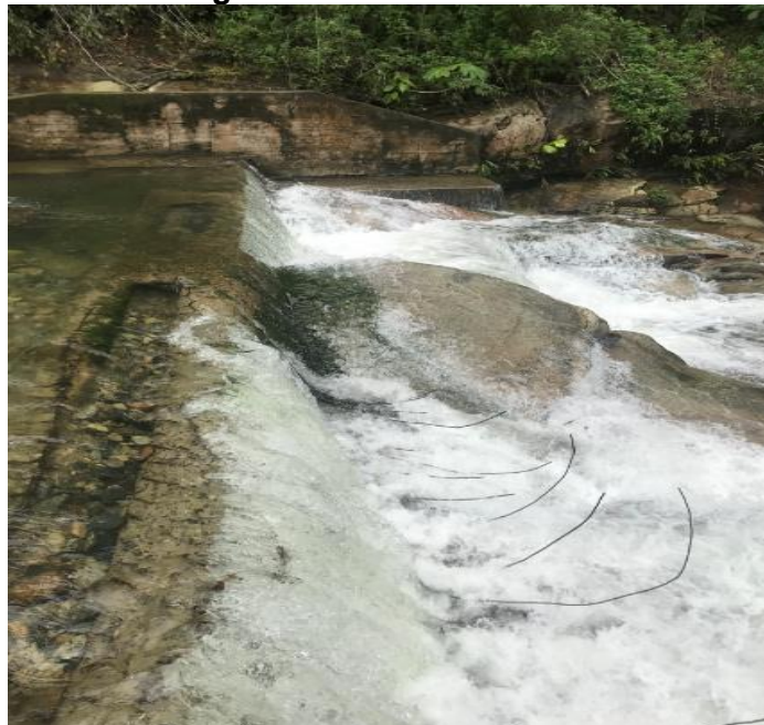
Estructura del dique Río Jerez
