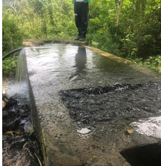
Desarenador Río Ancho
