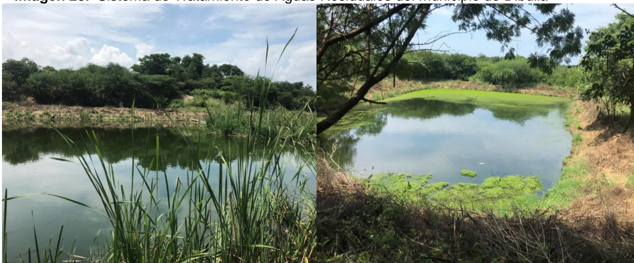
Imagen 28. Sistema de Tratamiento de Aguas Residuales del municipio de Dibulla
