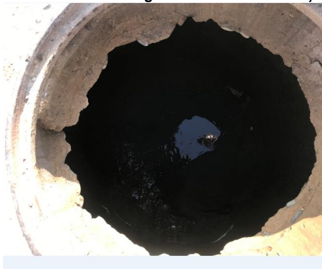
Manhole ubicado en la Carrera 10 calle 9: flujo normal, tapa en buen estado.
