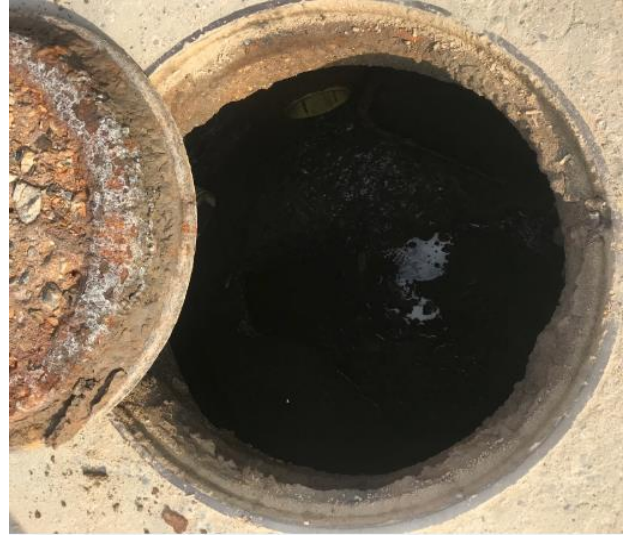
Manhole ubicado en la calle 6 carrera 5: flujo normal, tapa en buen estado
