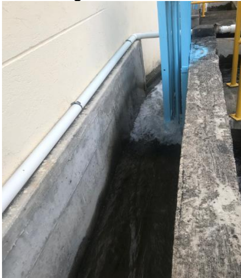
Canal de Entrada
