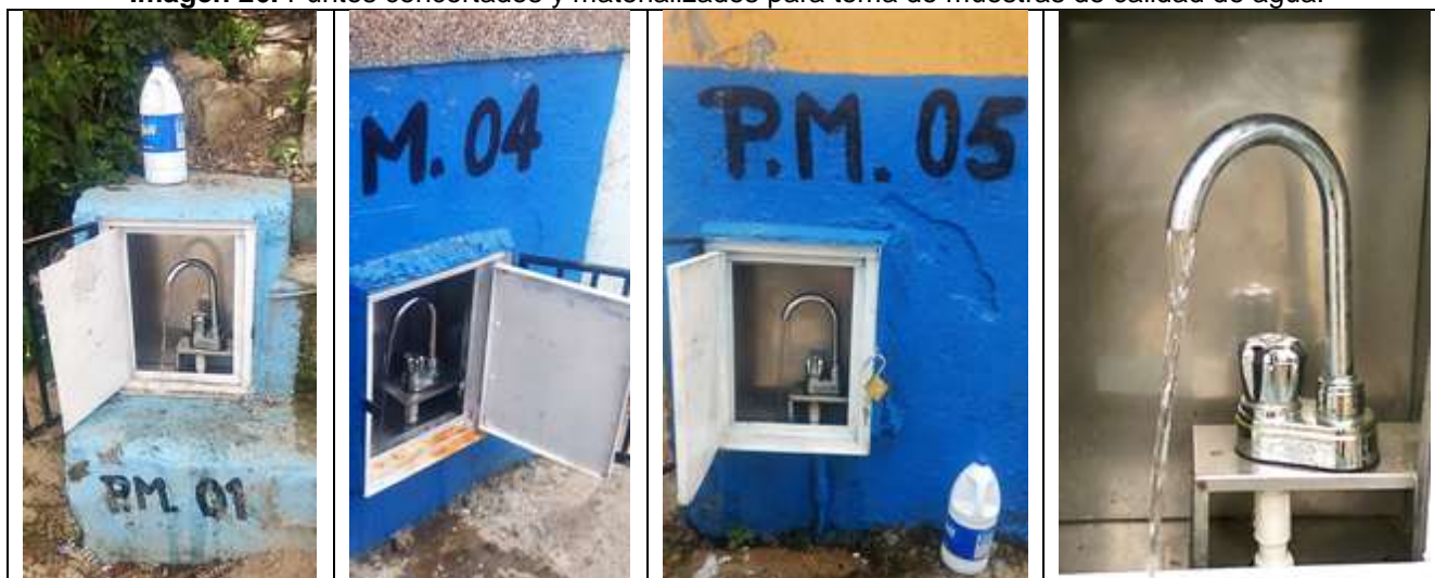
Imagen 26. Puntos concertados y materializados para toma de muestras de calidad de agua.
