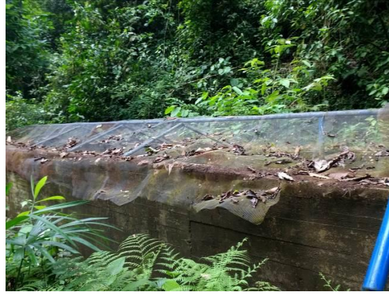
Imagen 9. Desarenador Quebrada Brava
