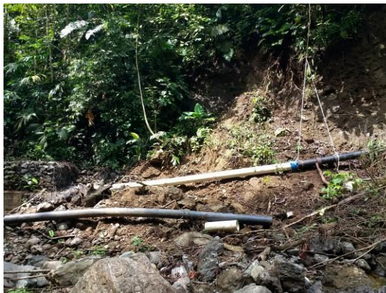
Imagen 11. Línea de aducción Quebrada Brava
