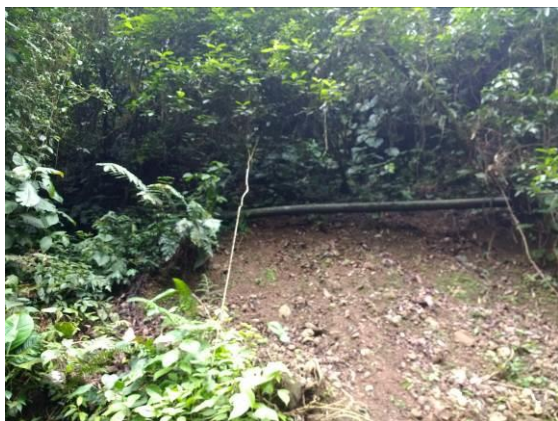
Imagen 10. Línea de aducción Quebrada Brava
