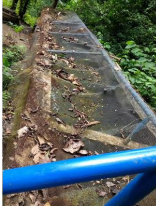
Imagen 8. Desarenador Quebrada Brava
