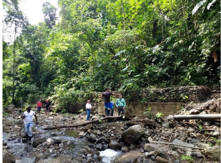
Imagen 22. Viaducto Quebrada Brava protegido por gaviones
