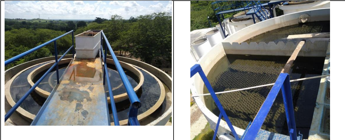
Imagen 10 y 11 Sedimentador de placas
