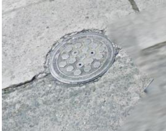
Imagen 12 Pozo de inspección
