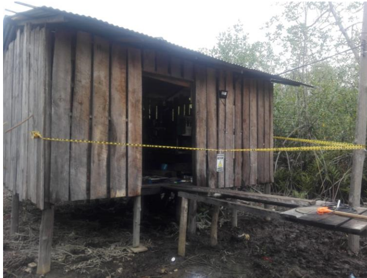
Imagen 2. Señalización y delimitación de áreas de trabajo
