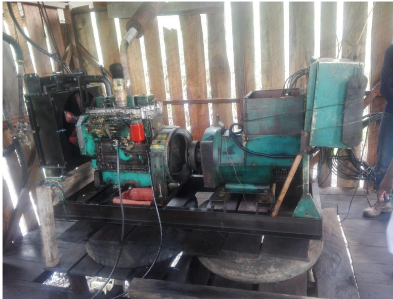
Imagen 1. Inspección visual de los equipos
