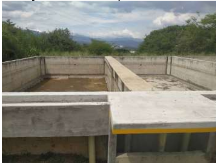
Imagen 22 Construcción tanques de almacenamiento
