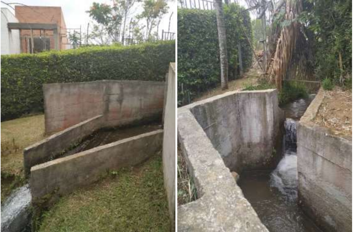
Imagen 11 Estructura de captación PTAP
