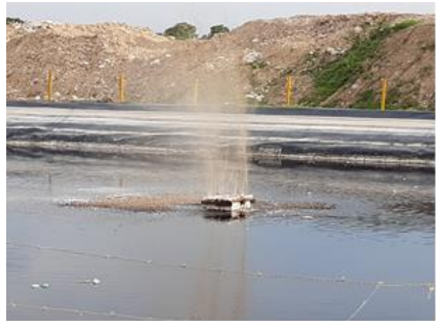
Foto 36. Detalle aspersión dentro de la piscina de lixiviados No. 1
