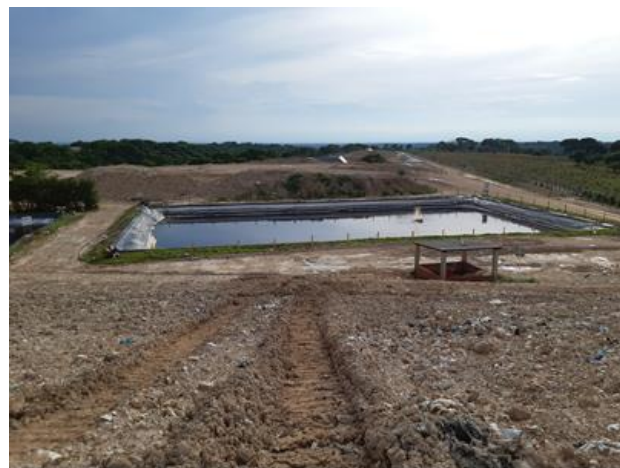
Foto 38. Piscina de almacenamiento de lixiviados
