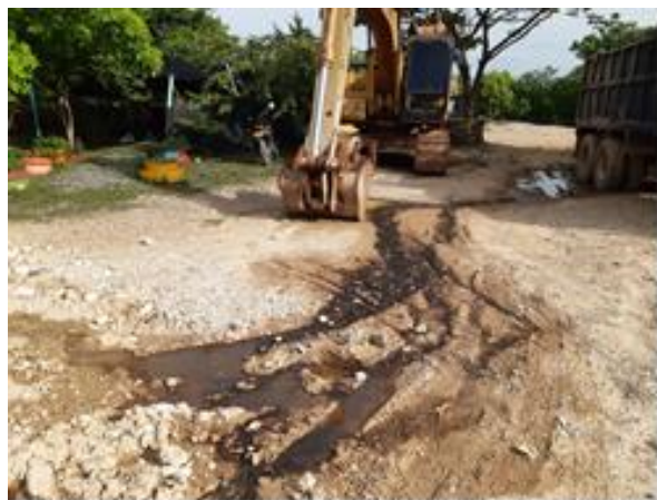
Foto 20. Acercamiento a reguero del área donde se encuentra la excavadora y volqueta de la foto anterior
