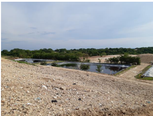
Foto 37. Piscinas de almacenamiento de lixiviados
