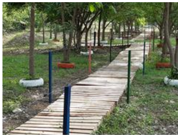
Foto 16. Avance construcción del sendero ecológico
