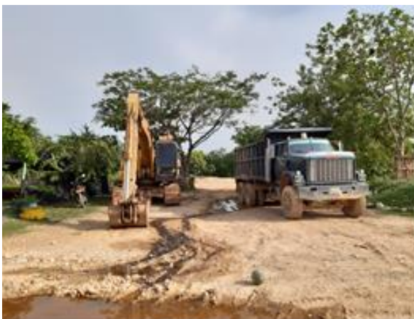
Foto 19. Retroexcavadora y volqueta estacionadas
