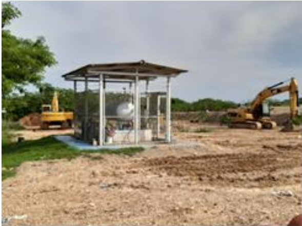
Foto 21. Vista de la ubicación de 2 retroexcavadoras
