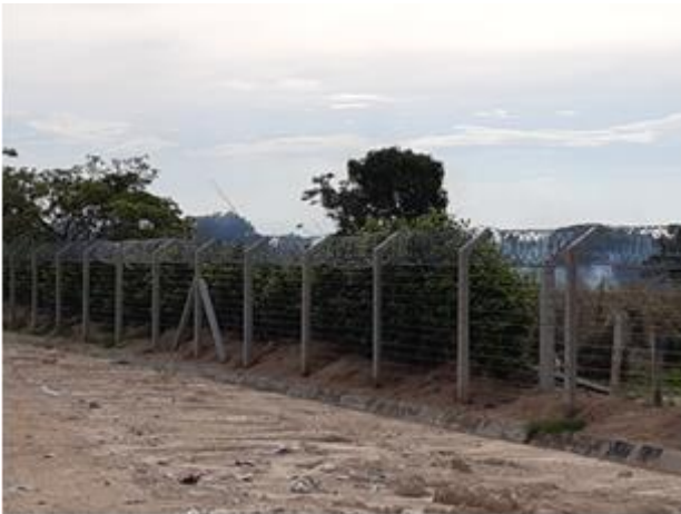
Foto 31. Cerramiento perimetral del sitio
