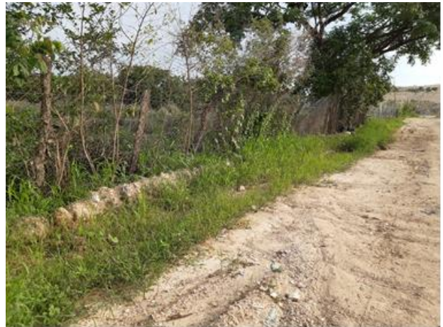
Foto 40. Cuneta perimetral para el manejo de escorrentía a un costado de la zona antigua
