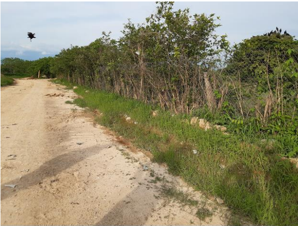
Foto 39. Cuneta perimetral para el manejo de escorrentía a un costado de la zona antigua
