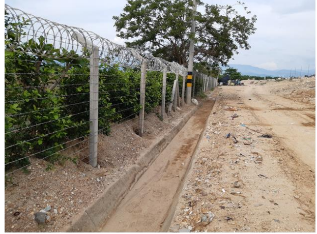
Foto 30. Cerramiento y cuneta perimetral para el manejo de escorrentía
