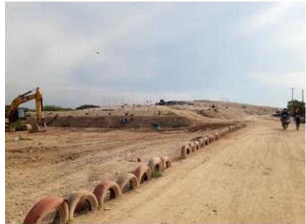
Foto 22. Vista vía de acceso y zona antigua
