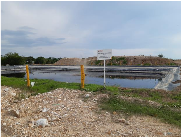
Foto 35. Piscina de almacenamiento de lixiviados
