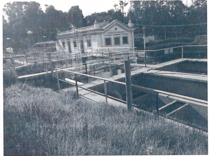
Fotografía 2. PTAP Antigua - Terebinto.
