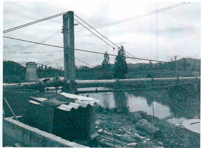
Fotografía 8. Bocatoma - Líneas de aducción de 14" y 16".
