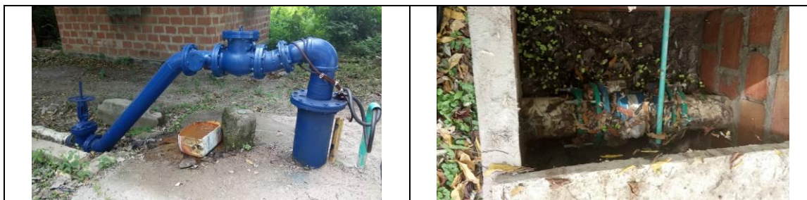
Fotos 1 y 2 Pozo Villa Lady
