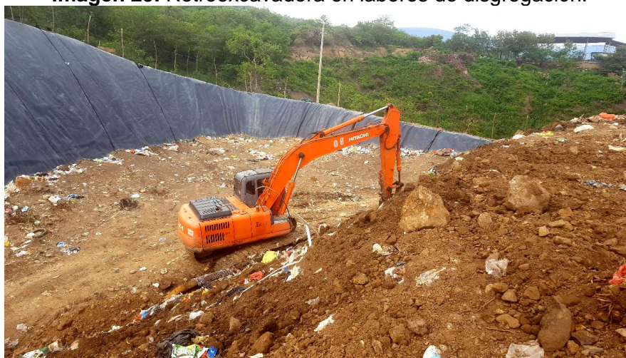
Imagen 29. Retroexcavadora en labores de disgregación.
