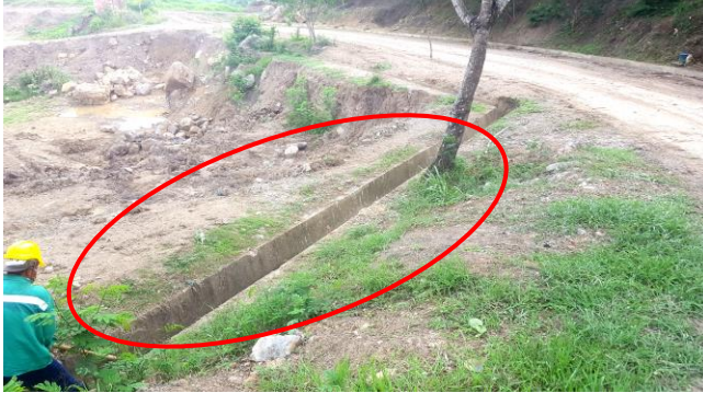
Imagen 23. Canales perimetrales parte 1.
