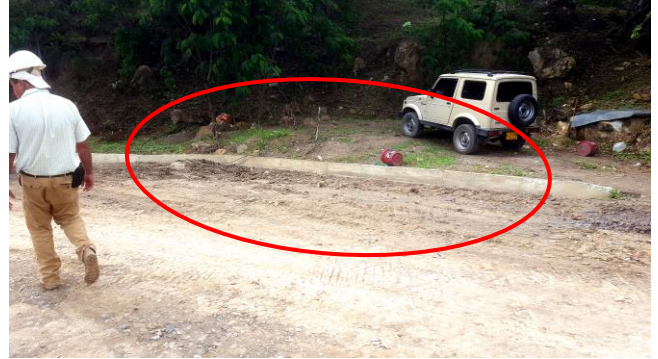
Imagen 24. Canales perimetrales parte 2.
