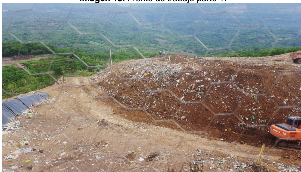
Imagen 19. Frente de trabajo parte 1.
