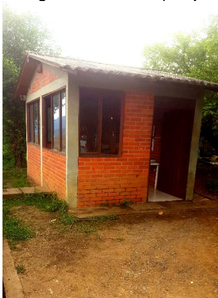
Imagen 15. Caseta de pesaje.
