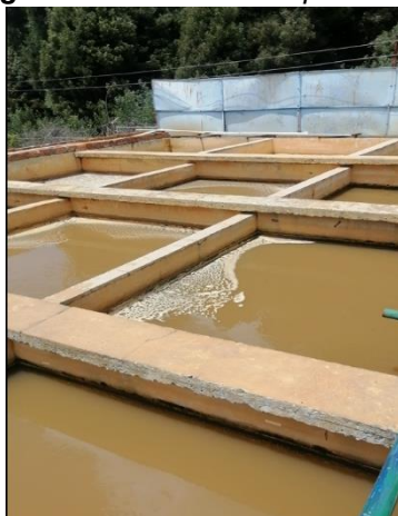
Imagen 37. Línea de lodos (lavado de los sedimentadores, floculadores y retrolavado de filtros) Dos tanques subterráneos, dos espesadores de lodos, un tanque de homogenización y un filtro prensa) – Optimización
