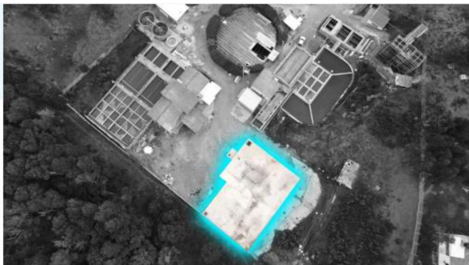
Imagen 32. Tanque de almacenamiento 1600 m 3 – Optimización
