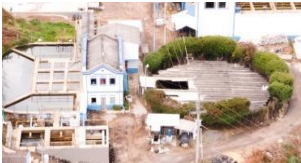
Imagen 39. Tanque de almacenamiento PTAP Terebinto
