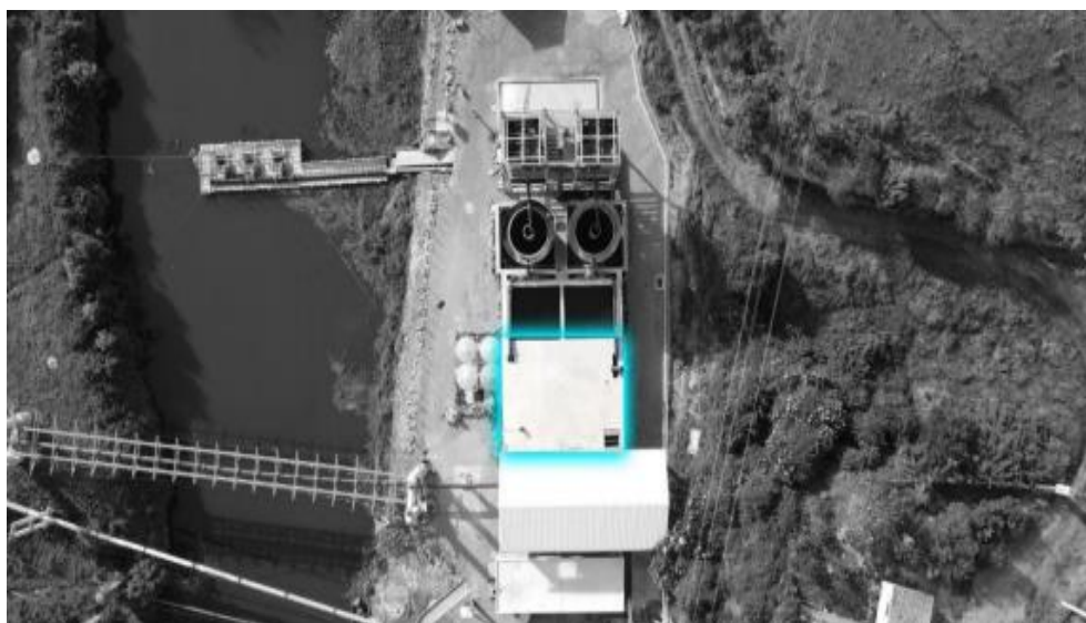
Imagen 15. Un tanque de transferencia
