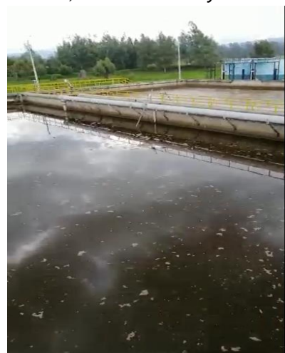
Imagen 60. Tanques SBR - Procesos de llenado, aireación, sedimentación y decantación
