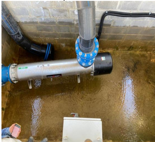
Imagen 31. Lámparas ultravioleta - Obra Optimización
