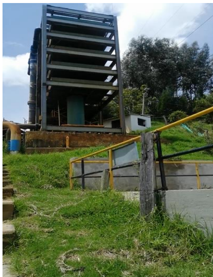
Imagen 25. Dos torres de aireación – Sección de cinco bandejas cada una
