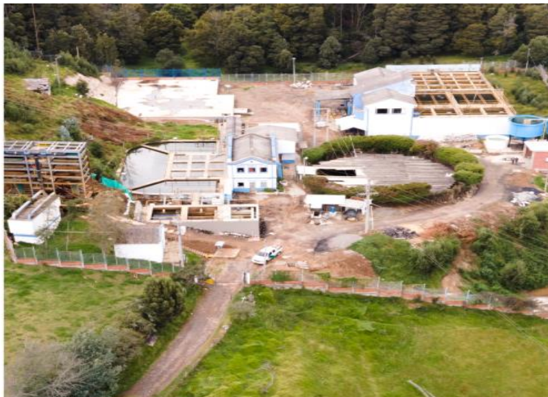
Imagen 24. Planta de Tratamiento de Agua Potable PTAP “Terebinto”
