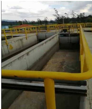
Imagen 60. Tanques SBR - Procesos de llenado, aireación, sedimentación y decantación
