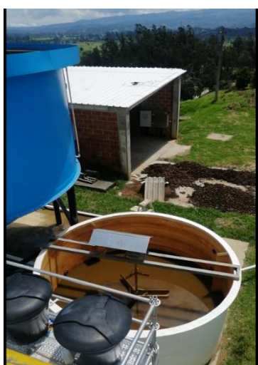
Imagen 38. Cuatro filtros descendentes con arena, grava y antracita
