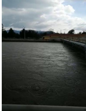
Imagen 55. Toma de muestras del reactor cuando el tanque está en aireación
