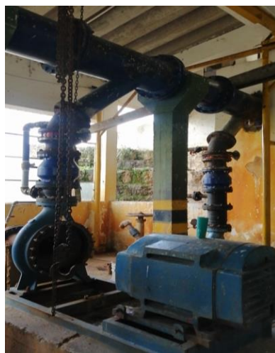
Imagen 8. Bombas de Impulsión
