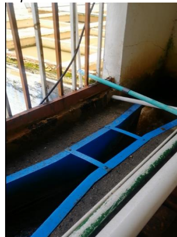
Imagen 33. Canaleta Parshall – Obra Optimización
