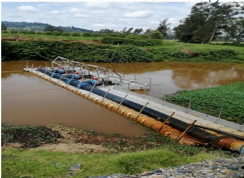
Imagen 11. Barcaza flotante con tres bombas de succión de 50Hp y línea de succión
