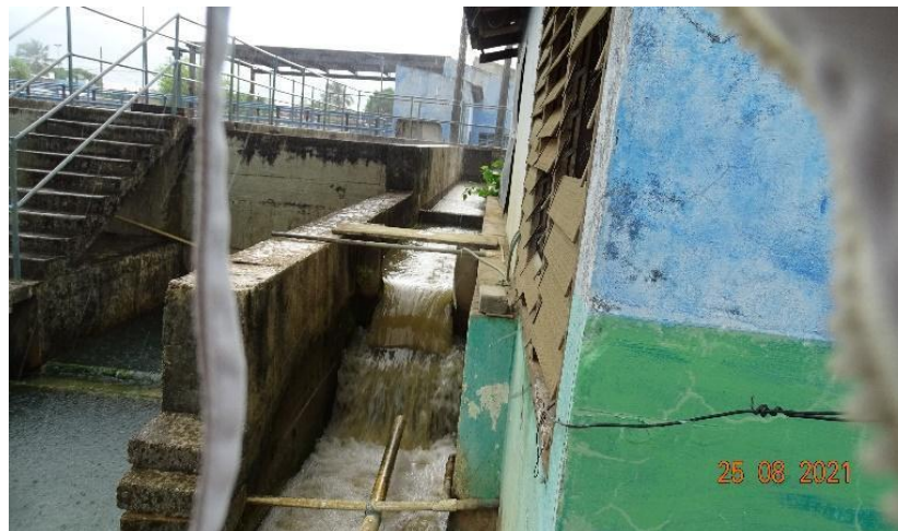
Imagen 66 Adición de las sustancias coagulantes
