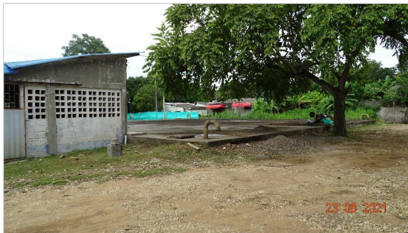
Imagen 26 Tanques de almacenamiento “Aguas Claras”
