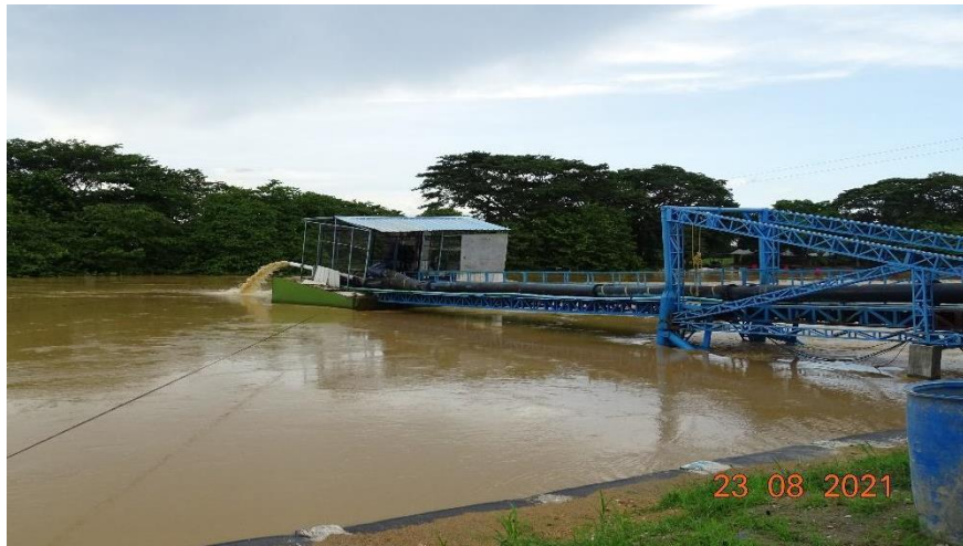
Imagen 13 Línea de Aducción
