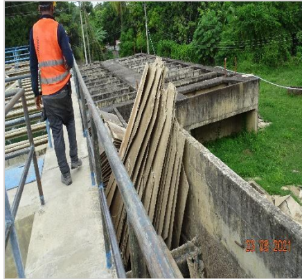
Imagen 21 Retiro de lámina se AC de los sedimentadores agosto 2021
