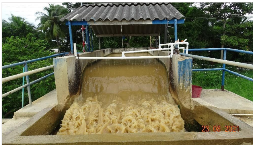
Imagen 17 Canal de entrada – tipo vertedero
