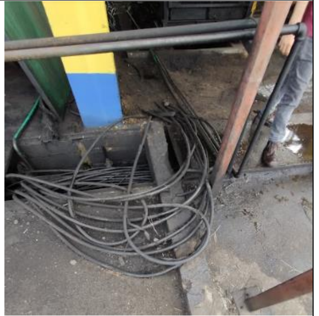
Conductores sin canalizar.
