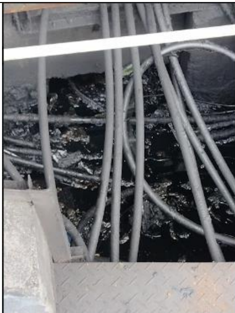
Cárcamos con aceite y conexiones con riesgo eléctrico.
