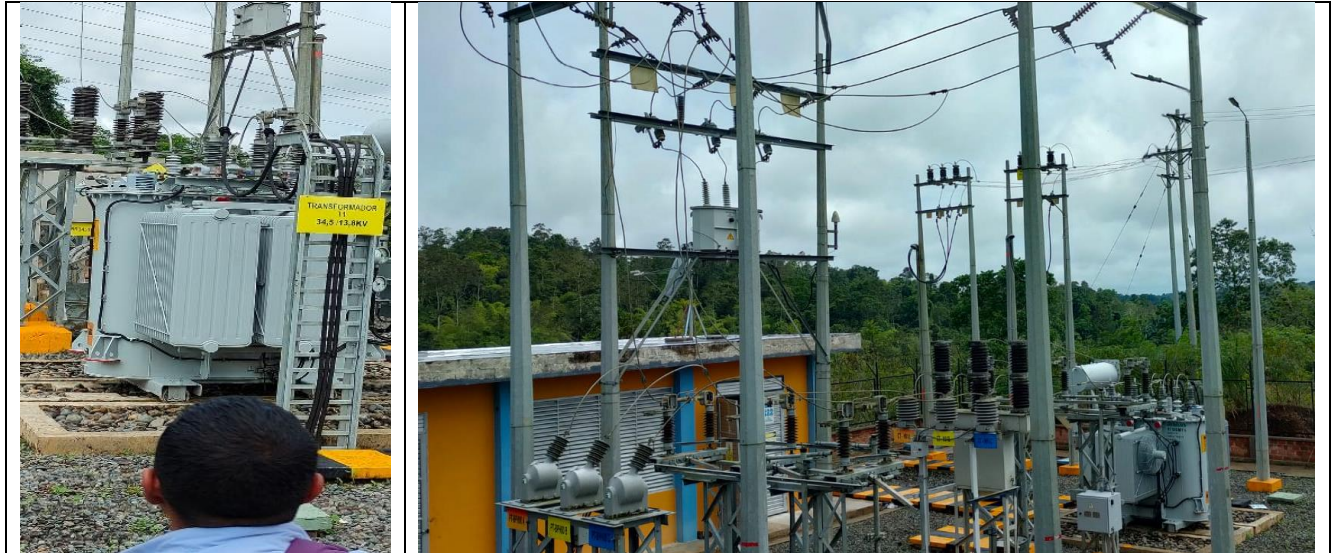
Fuente: Registro fotográfico SSPD 21 de septiembre de 2022.
