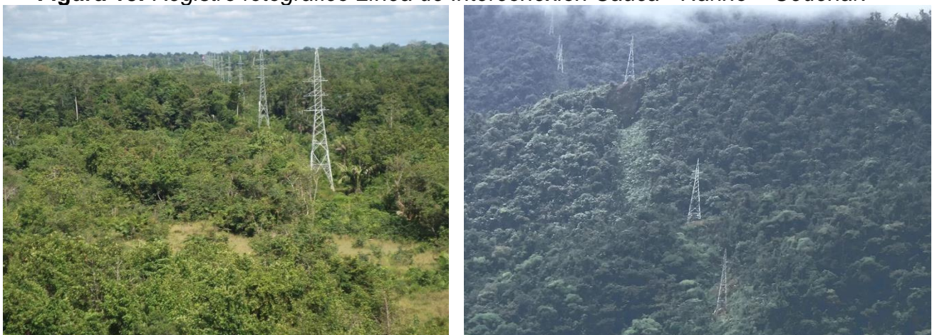
Figura 15. Registro fotográfico Línea de Interconexión Cauca - Nariño – Cedenar.
