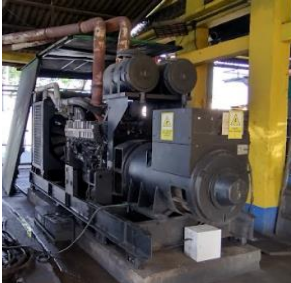
Unidades 6 y 7 - Unidades de generación CUMMINS QST30G3 (En mantenimiento)
