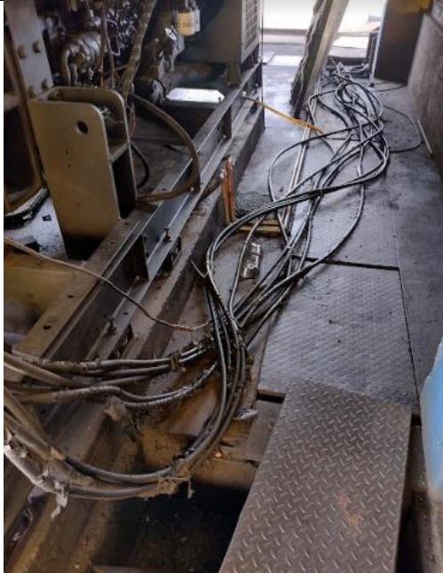
Conductores sin canalizar.
