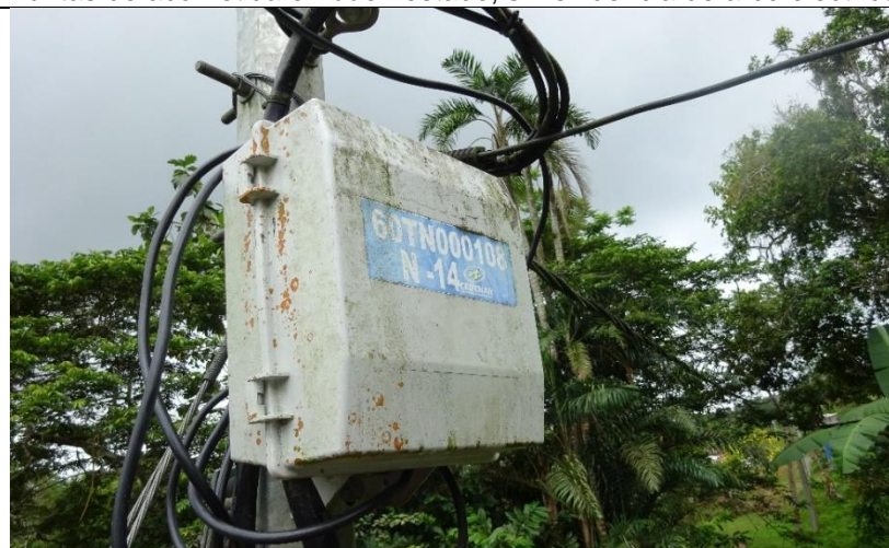
Caja de abonados en buen estado, sin evidencia de falla eléctrica Instalaciones internas vulnerables y antitécnicas
