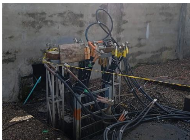
Terminales de conexión del transformador 3 y subestación.
