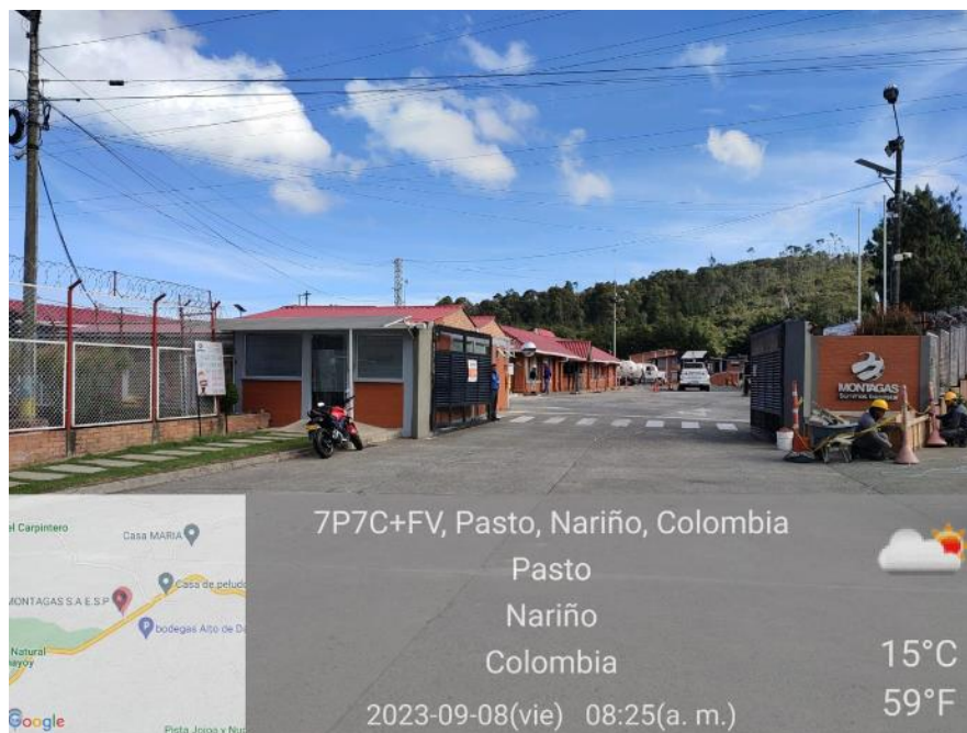
Figura 4. Fotografías instalación física de la Planta de Envasado MONTAGAS S.A. E.S.P. – San Juan de Pasto, Nariño
