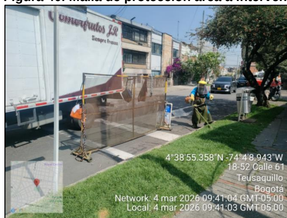
Figura 40. Malla de protección área a intervenir
