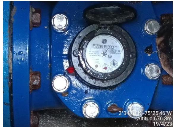
Imagen 12. Estructura que contiene el macro medidor (no operativo) de la línea de aducción principal
