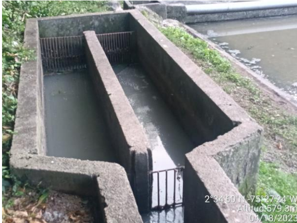
Canal de entrada, desarenadores, rejillas gruesas y finas deterioradas.
