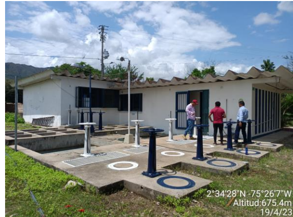
Vista interna de la PTAP.
