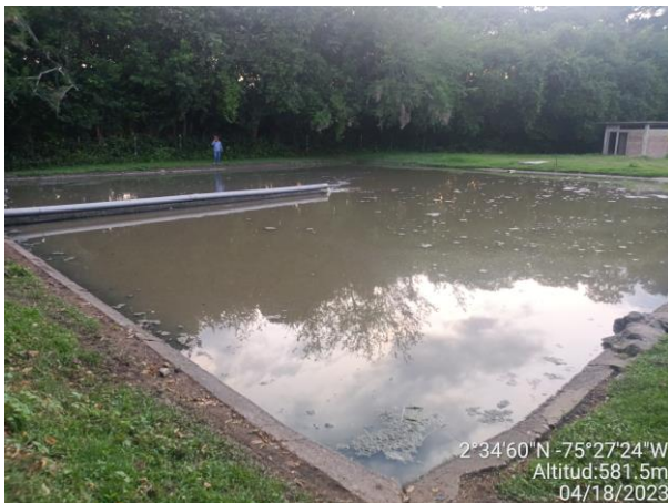
Laguna de oxidación 1.
