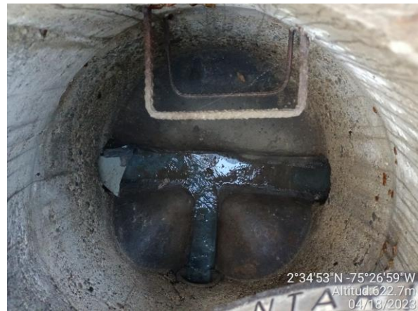
Imagen 22. Pozos de inspección del sistema de alcantarillado combinado.
