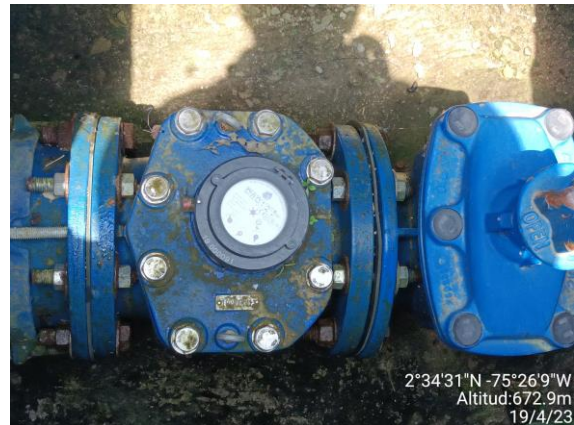
Imagen 13. Estructura que tiene el macro medidor al ingreso de los tanques de almacenamiento semienterrados de agua tratada
