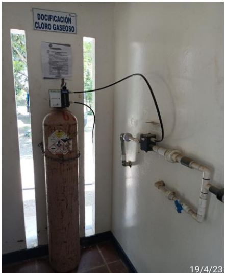
Imagen 10. Sedimentadores, dosificación de cloro gaseoso.
