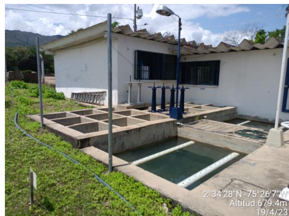
Canal de entrada, adición de coagulante y floculadores
