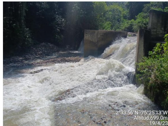
Estructura de captación
