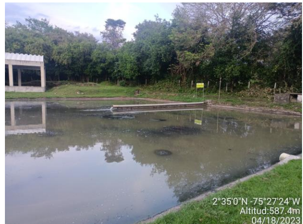
Laguna de oxidación 2.
