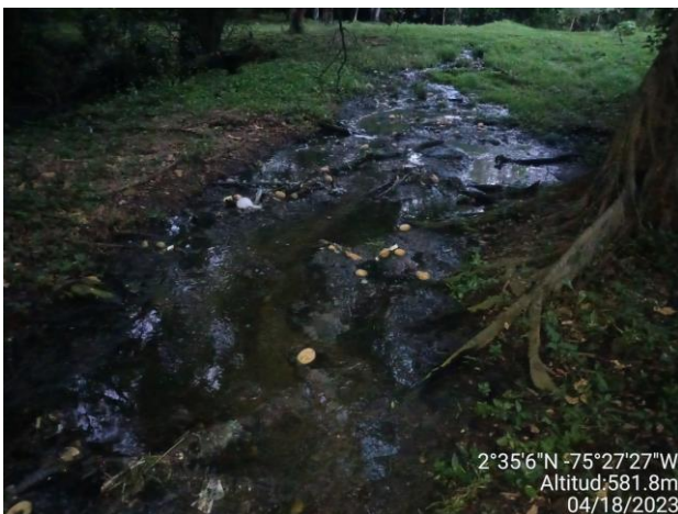
Vertimiento adicional de la laguna de maduración facultativa 5.
