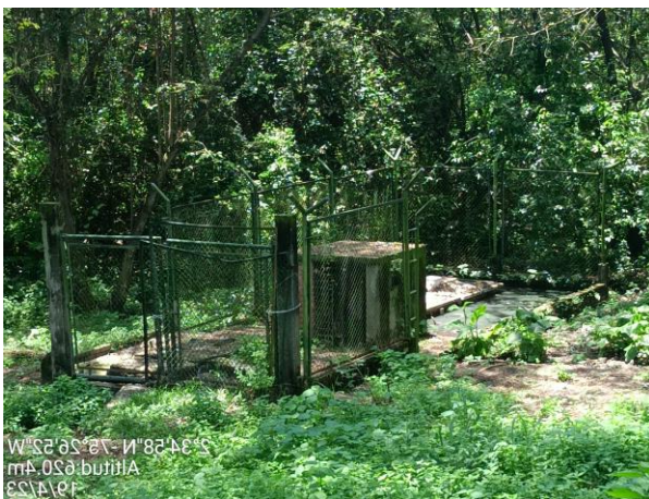
Imagen 25. PTAR Compacta “Pozo séptico”
