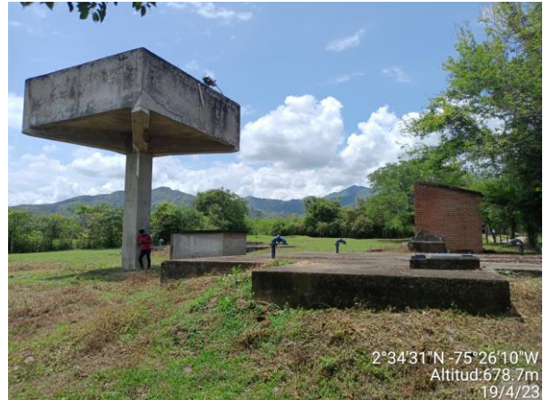
Imagen 11. Tanques de almacenamiento semienterrado, elevado y cuarto de máquinas (no operativos)
