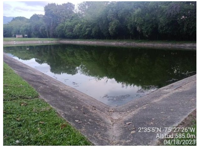
Laguna de maduración facultativa 6
