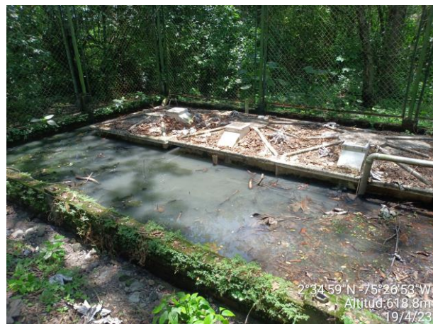
Imagen 25. PTAR Compacta “Pozo séptico”
