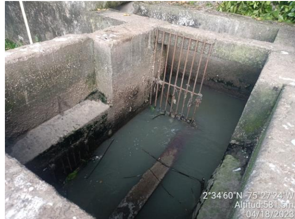
Canal de entrada, desarenadores, rejillas gruesas y finas deterioradas.
