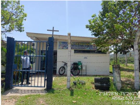
Vista externa de la PTAP.
