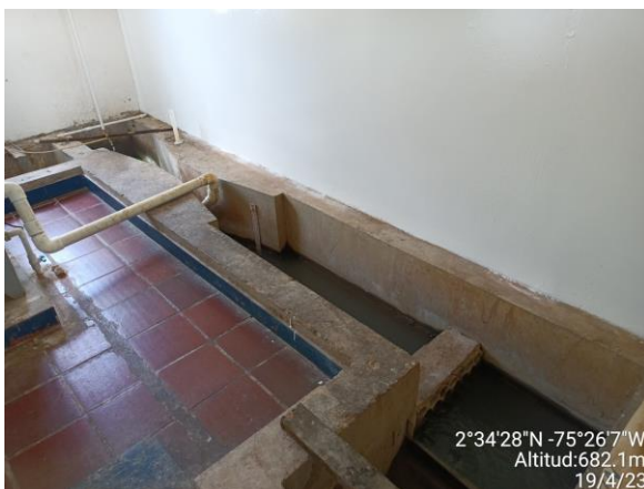
Canal de entrada, adición de coagulante y floculadores
