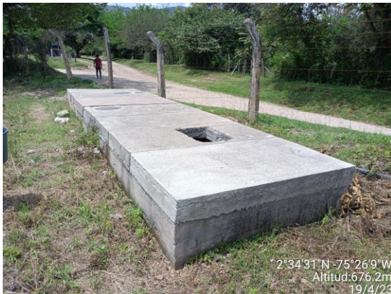
Imagen 13. Estructura que tiene el macro medidor al ingreso de los tanques de almacenamiento semienterrados de agua tratada
