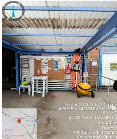
Foto 15 Ubicación de camilla, extintor y botiquín a la entrada de la base de operaciones
