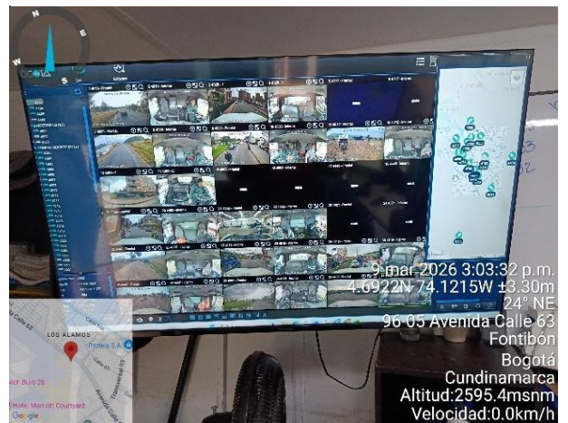
Foto 8 Sistema CEIBA 2, para monitoreo en tiempo real de la actividad de recolección y transporte desde zona de control de operaciones
