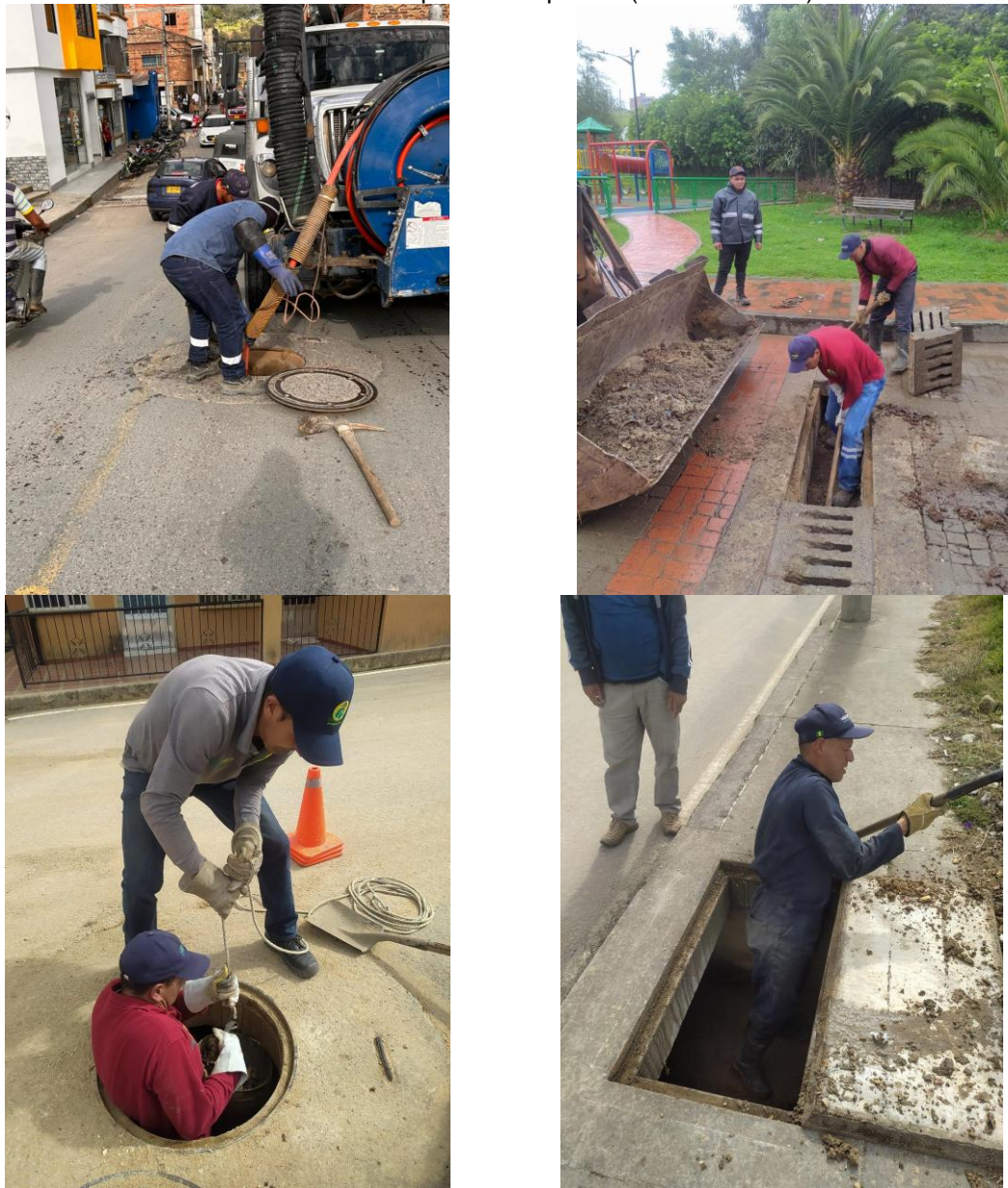
Imagen 7. Registro fotografico de los mantenimientos realizados a los componentes del sistema de alcantarillado del municipio de Villapinzón (Cundinamarca)
