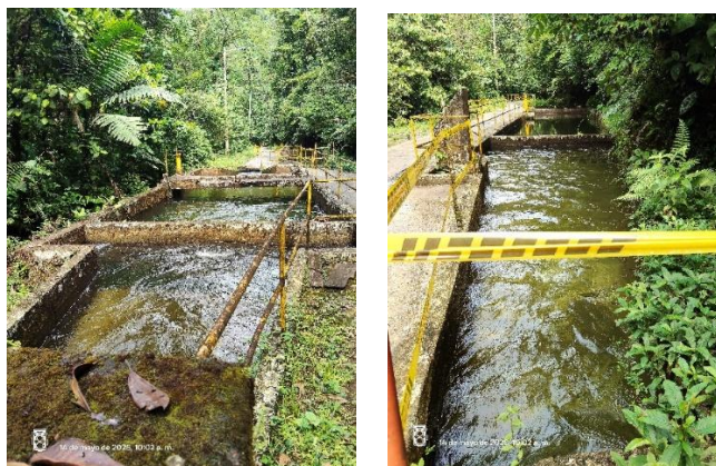
Imagen 4: Desarenadores existentes
