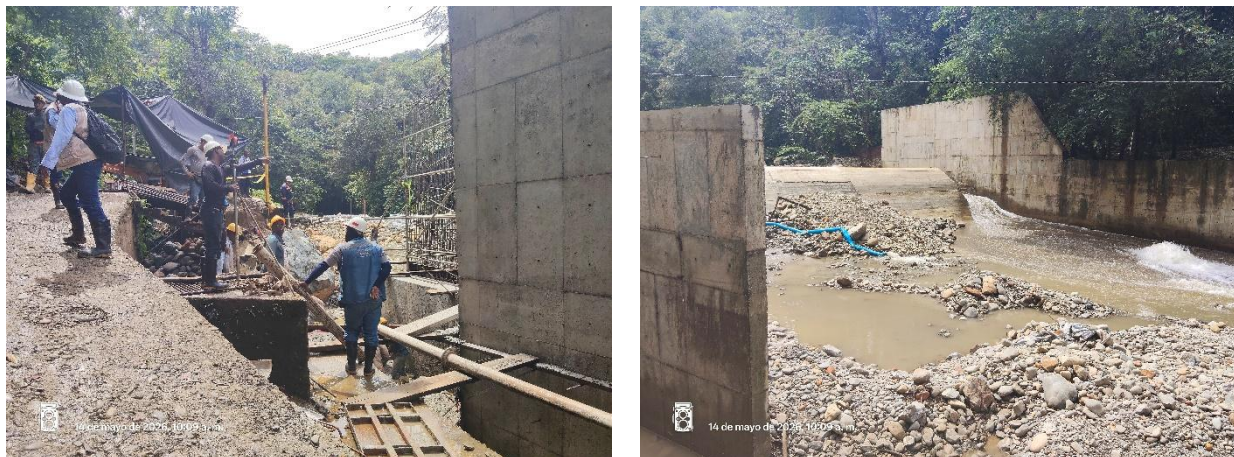
Imagen 5: Obra de optimización (desarenador y bocatoma)
