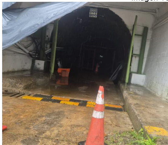
Ingreso galería Ventana
