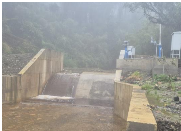
Estructura de captación Charrascal
