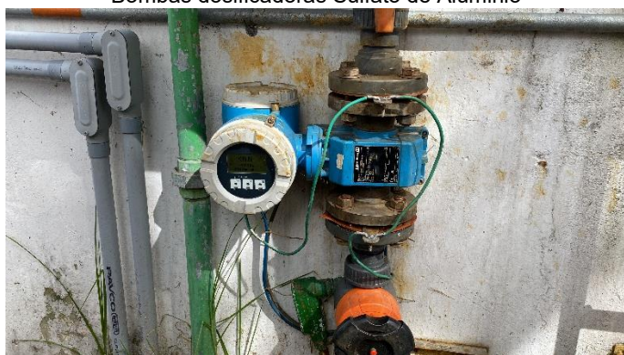
Caudalímetro de los productos de dosificación
