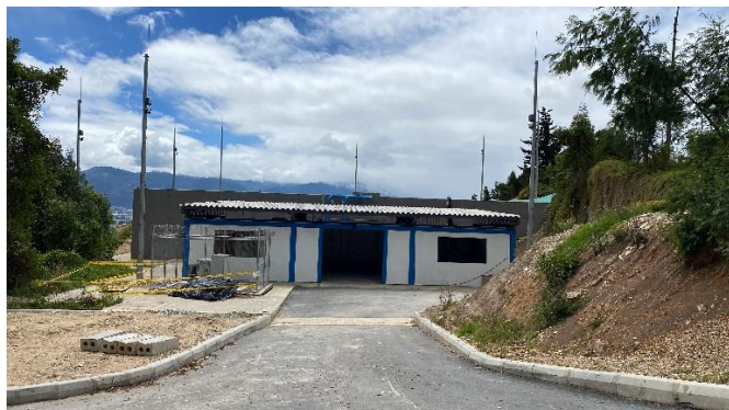
Infraestructura proceso de tratamiento de lodos
