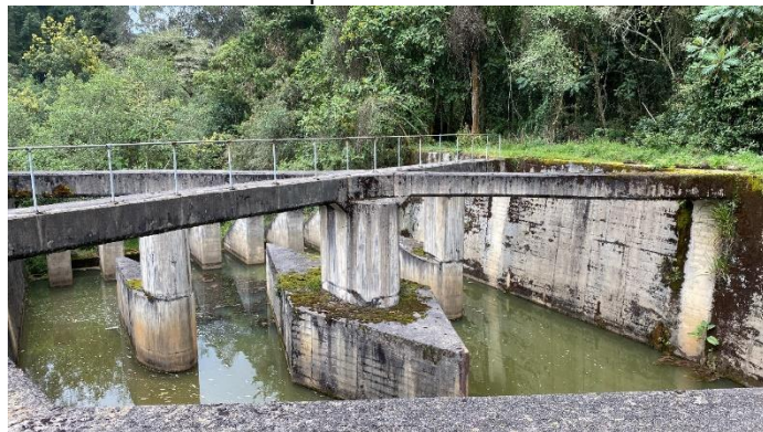
Disipador de energía
