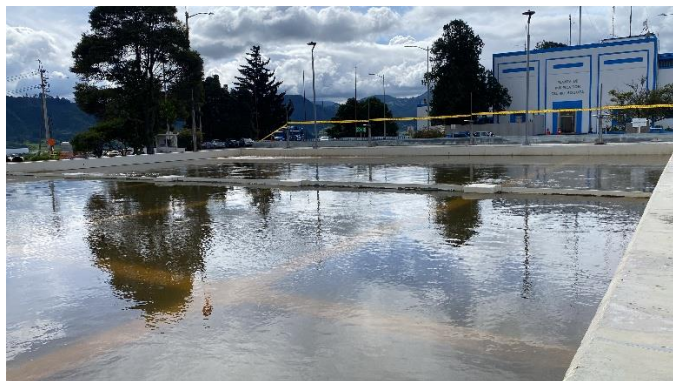
Unidades de sedimentación optimizada
