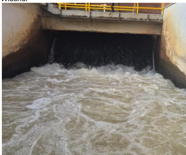
Estructura hidráulica de agitación V52
