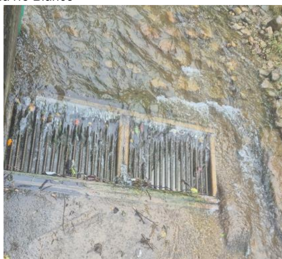
Bocatoma de fondo Pozo 1
