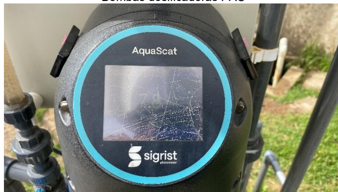
Turbidímetro al ingreso del canal de aducción
