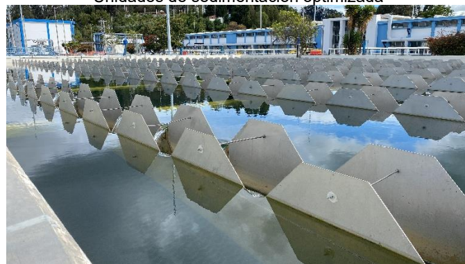
Lámelas de sedimentación
