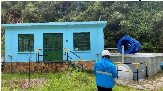
Cuarto de control y descarga
