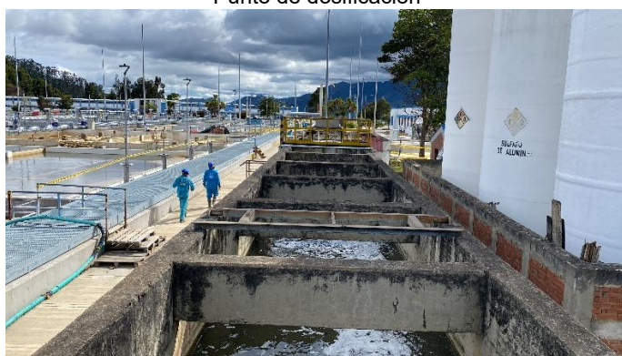
Vertedero de control
