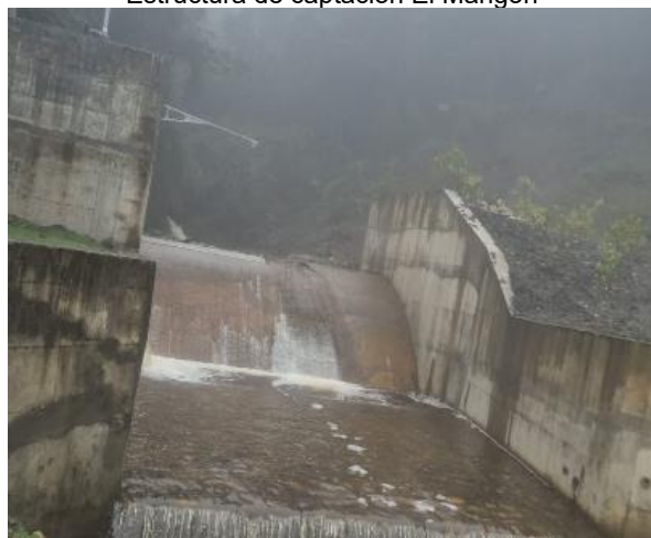
Estructura de captación Calostros
