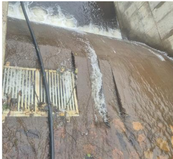
Bocatoma de fondo El Mangón
