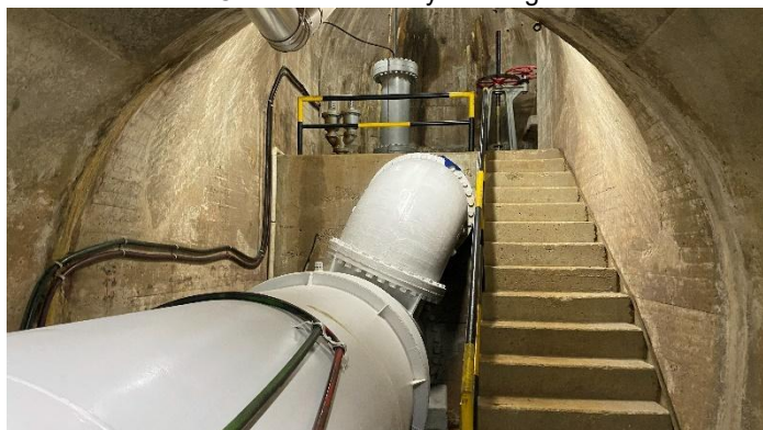
Válvulas reguladoras de caudal
