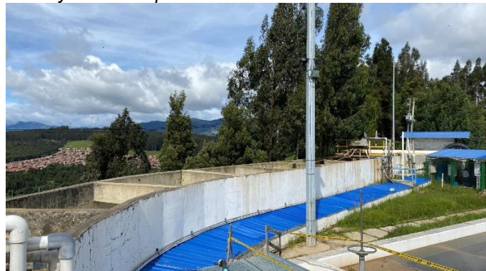
Canal de aducción
