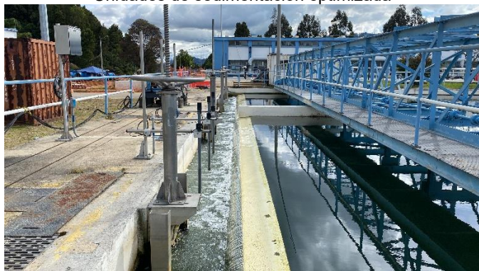
Canal de clarificada
