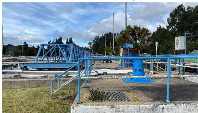
Canal de clarificada
