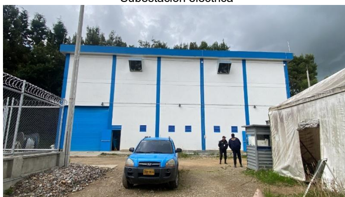
Infraestructura equipos electrónicos
