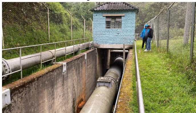
Tubería de descarga
