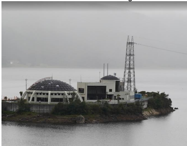
Estación de Bombeo
