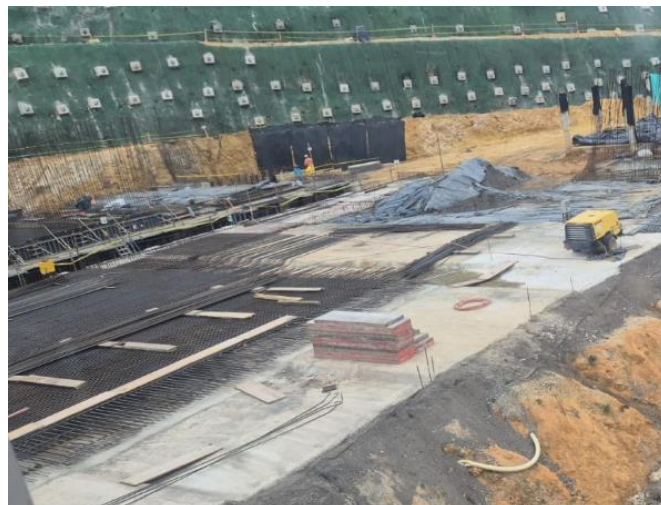
Placa de Fondo Filtros Nuevos Costado Sur:
