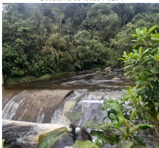
Sistema de captación pozo 2
