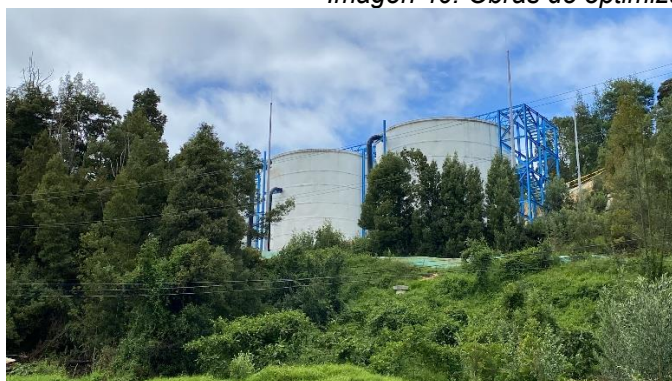
Tanques de homogenización
