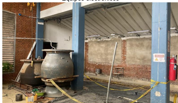
Estación de bombeo en obra
