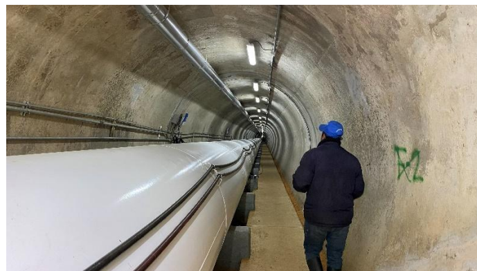
Tubería de descarga
