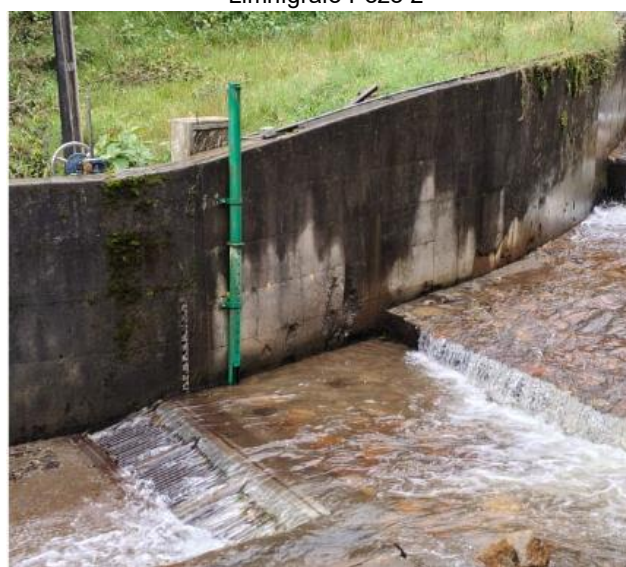
Mira milimétrica Pozo 4
