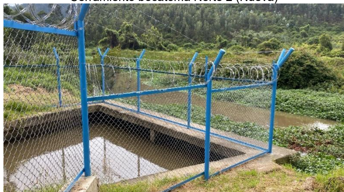
Bocatoma Norte 2 (Nueva)
