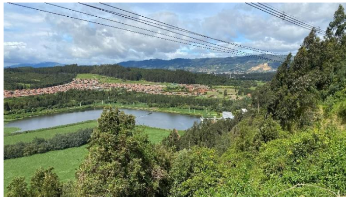
Dársena de presedimentación cubierta por buchón
