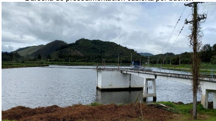
Espejo de agua cruda dársena de presedimentación
