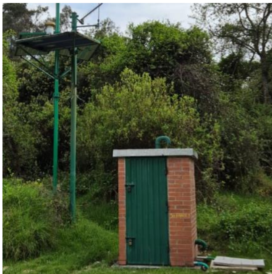
Estación Puente Francis
