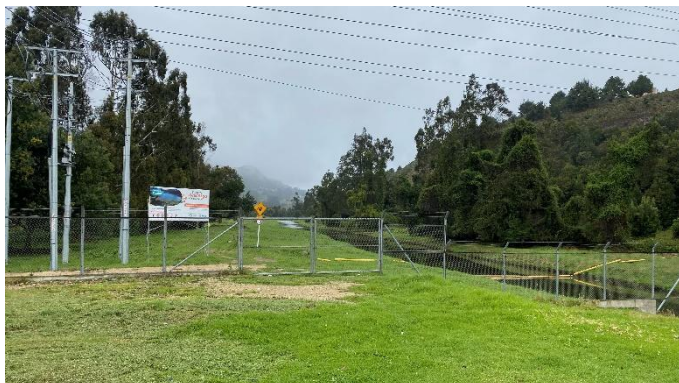
Zona de descarga Canal Achury
