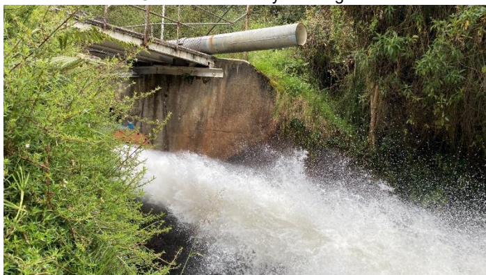
Descarga del caudal embalsado
