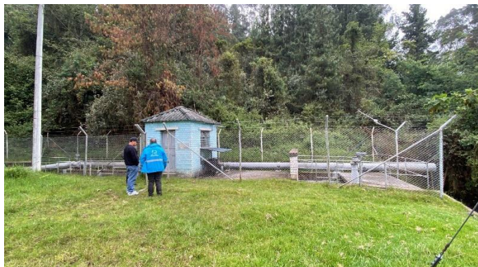
Cuarto de control y descarga
