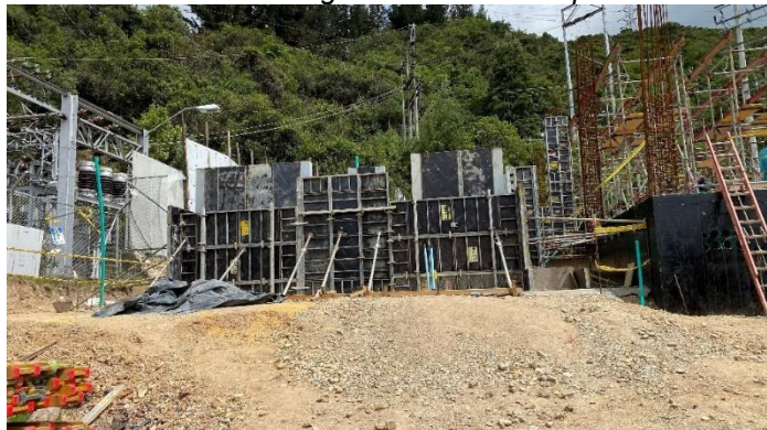
Subestación eléctrica en construcción
