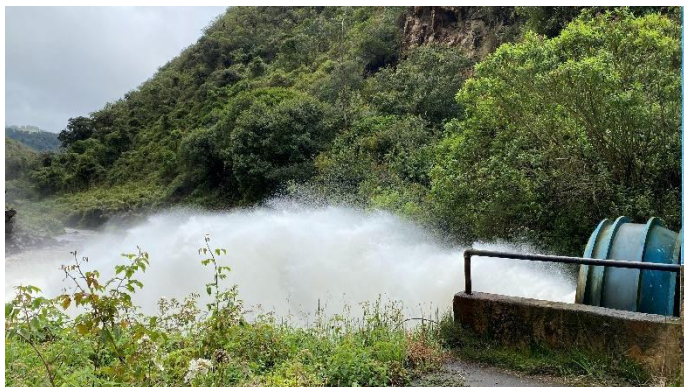
Descarga del caudal embalsado
