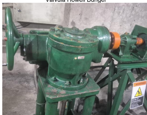
Operador válvula HB
