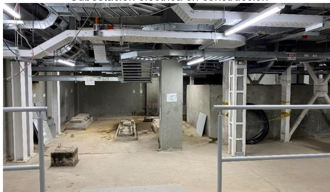
Obras de modernización
