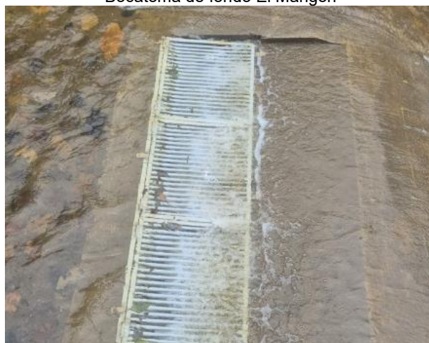
Bocatoma de fondo Calostros
