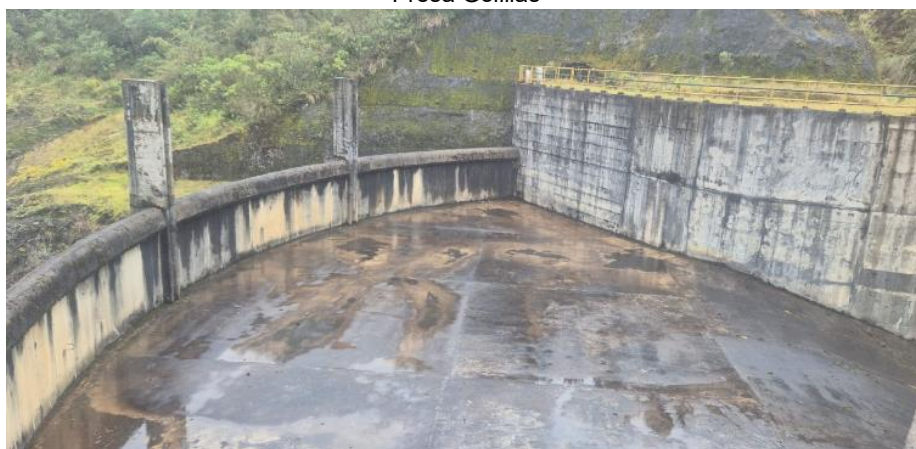
Estructura de rebose presa Golillas
