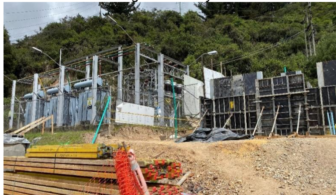
Subestación eléctrica en construcción
