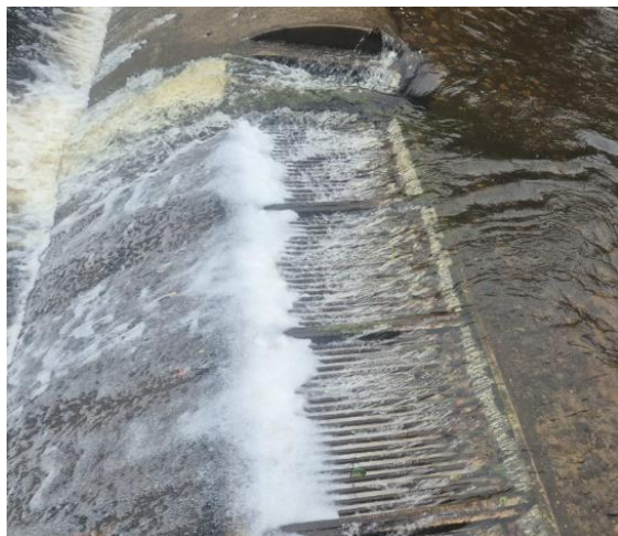
Bocatoma de fondo pozo 2
