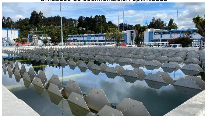
Lámelas de sedimentación
