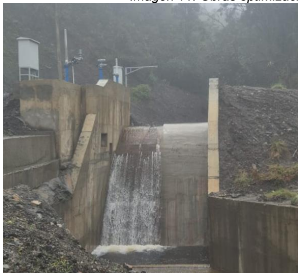
Estructura de captación Barro – Plumaraña
