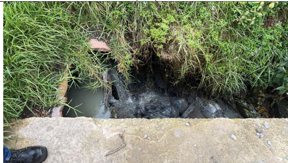
Punto de vertimiento Quebrada Aguasal
