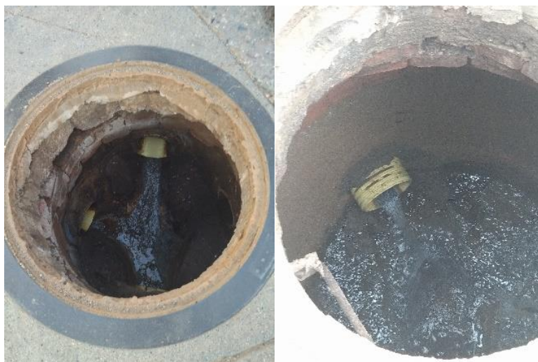
Imagen 15. Pozos de inspección
