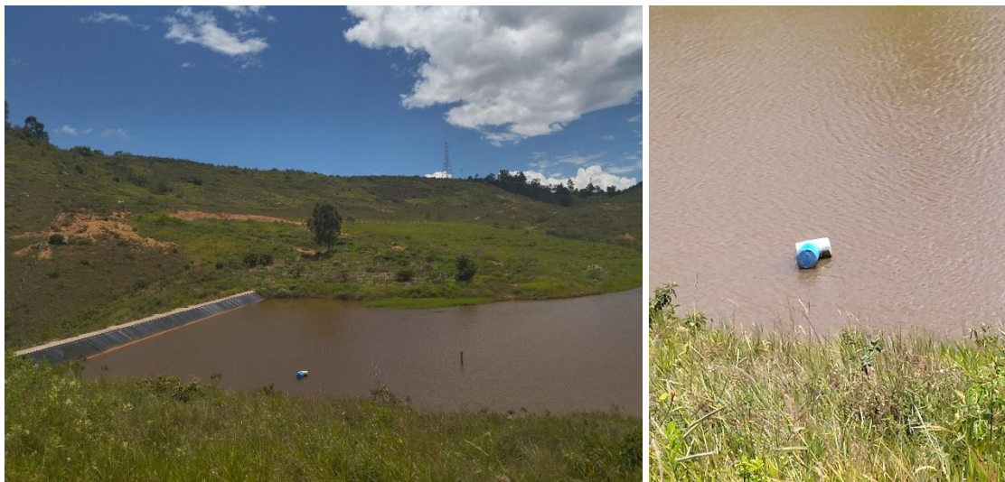
Imagen 7. Bocatoma Embalse Los Pozos
