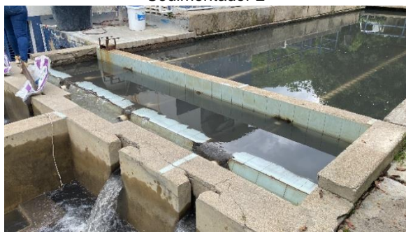
Salida sedimentador 2
