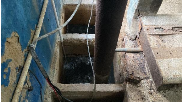
Tanque de bombeo
