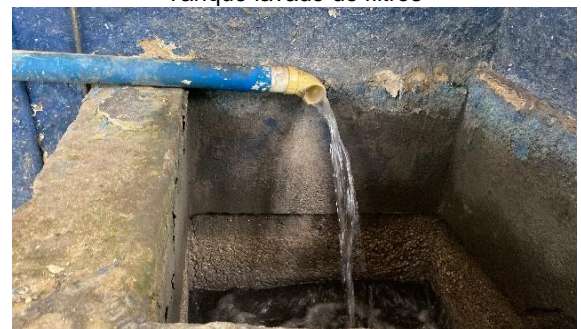
Aplicación del coagulante de sulfato de aluminio
