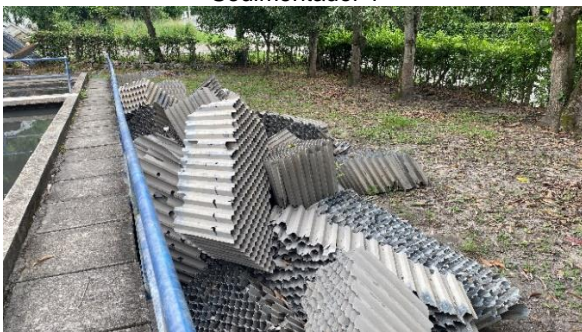
Placas tipo colmena del sedimentador 2
