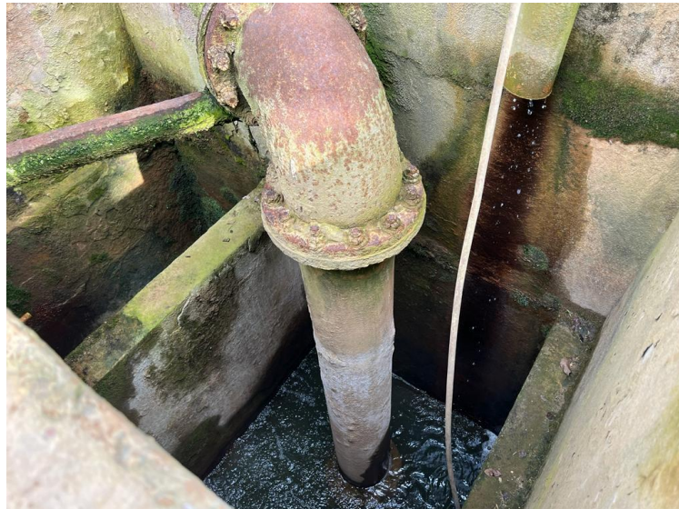
Imagen 13. Estructuras de ingreso a la PTAP.
