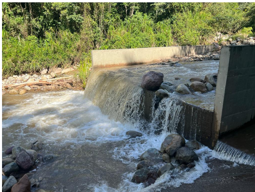
Imagen 5. Quebrada Cinco Mil – Captación.
