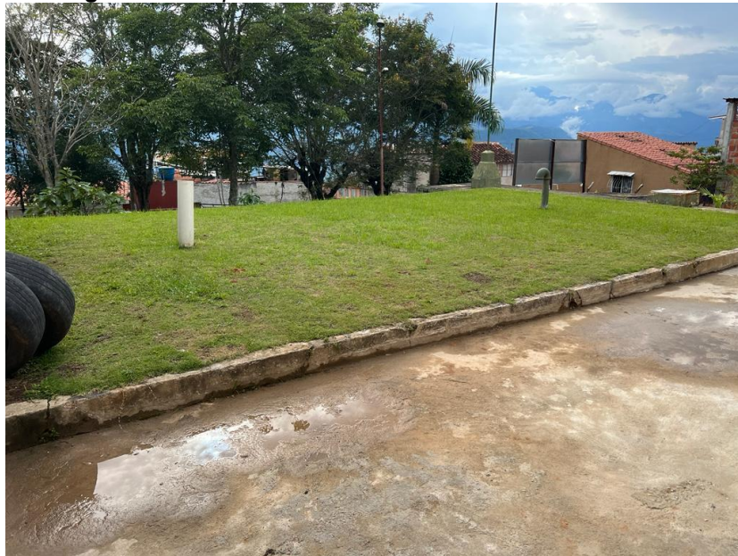
Imagen 30. Tanques de almacenamiento PTAP Convencional.
