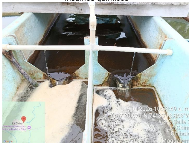
Imagen 27. Vertedero en V con aplicación de insumos químicos
