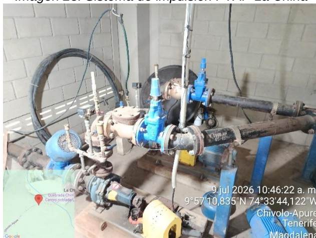
Imagen 25. Sistema de impulsión PTAP La China
