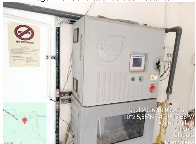
Imagen 16. Generador de desinfectante
