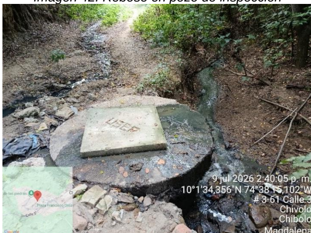
Imagen 42. Rebose en pozo de inspección
