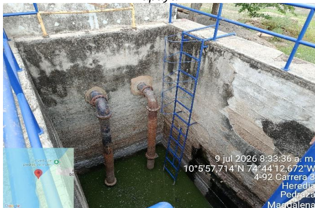
Imagen 6. Alberca de captación de la ciénaga Zapayán
