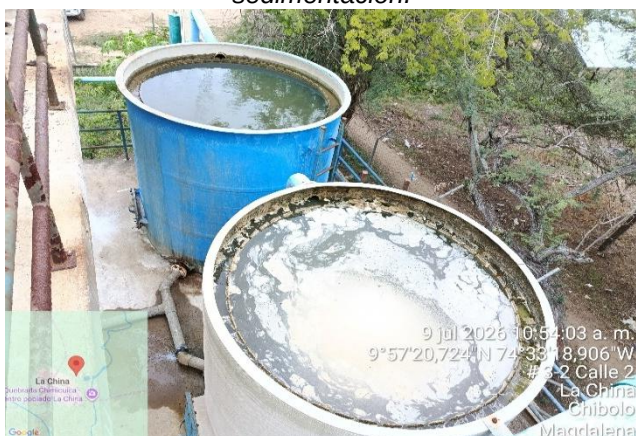
Imagen 28. Unidades de Floculación y sedimentación.
