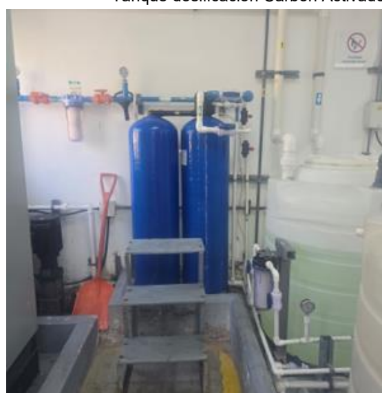
Sistema de preparación de cloro
