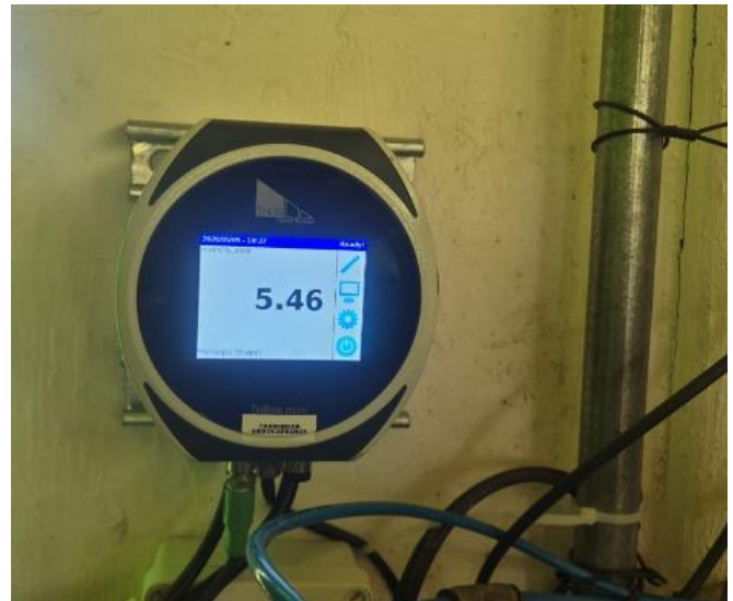
Sensor hidrocarburos
