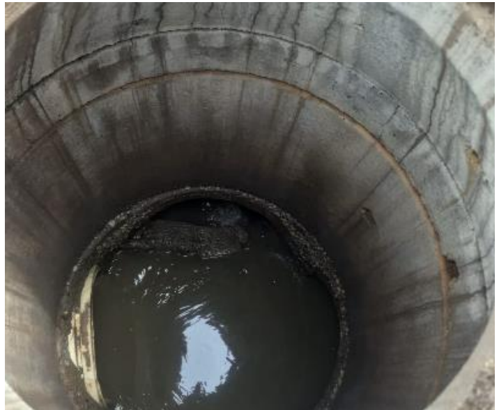
Aliviadero interceptor margen derecha
