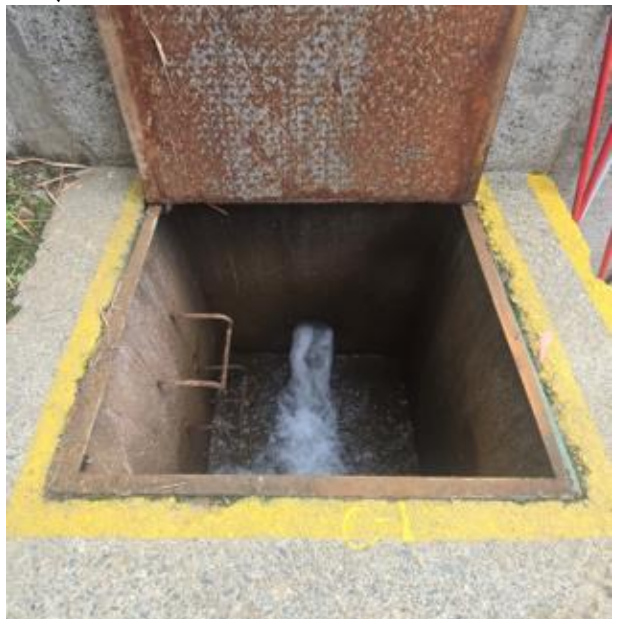
Tanque desarenador
