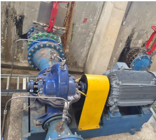
Bomba centrífuga de 260 l/s
