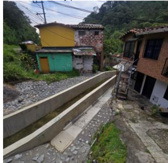
Canal de descarga Caldas
