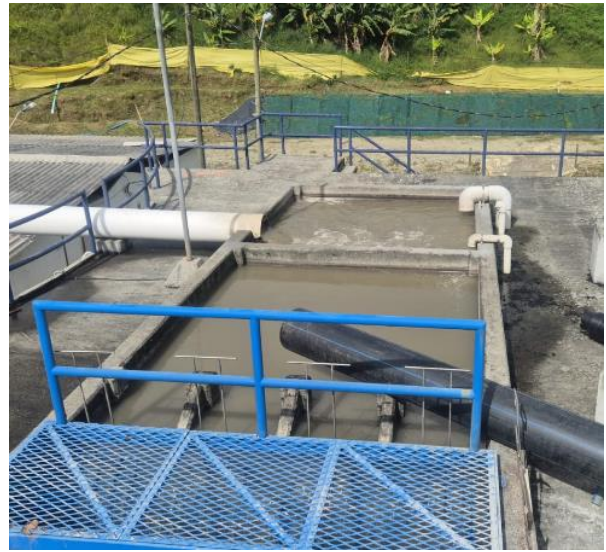
Estructura de repartición de caudales
