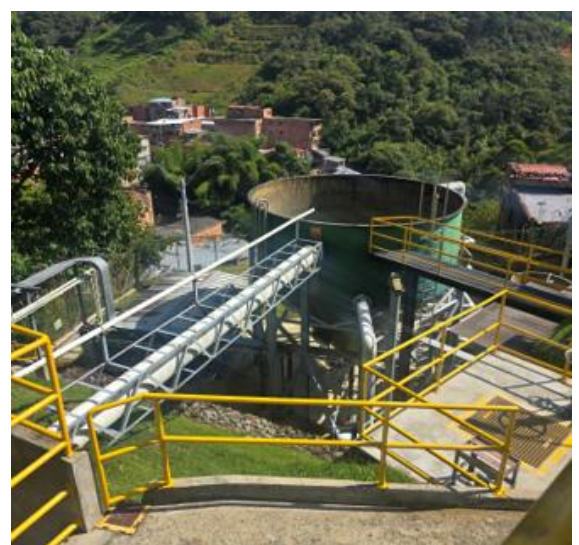
Tanque de homogeneización y pre-espesado
