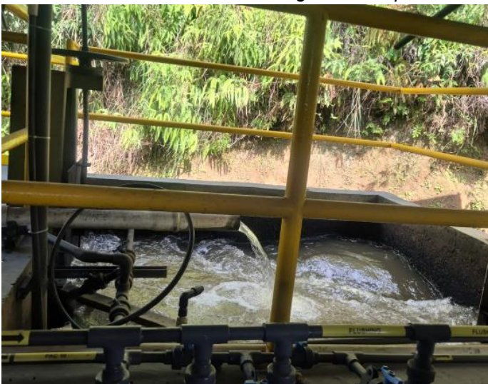
Cámara de Llegada
