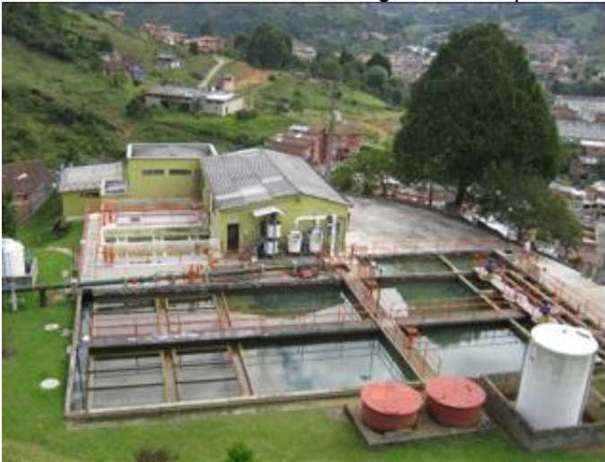
Vista general Planta de Potabilización Caldas
