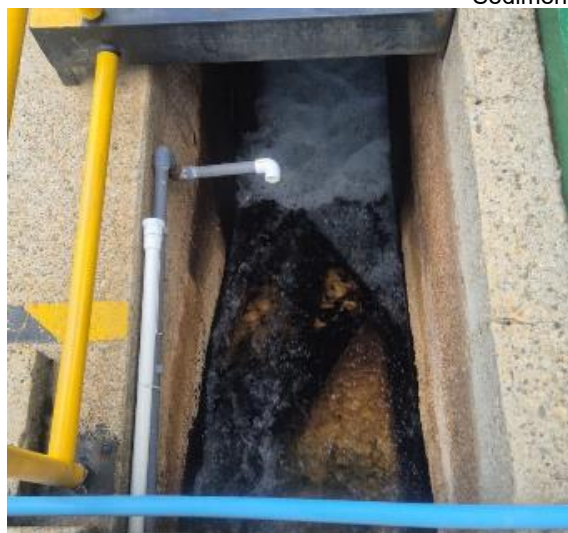
Aplicación hipoclorito de sodio previo a filtros
