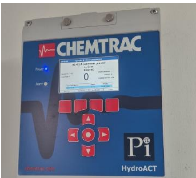
Monitor de corriente de flujo Chemtrac
