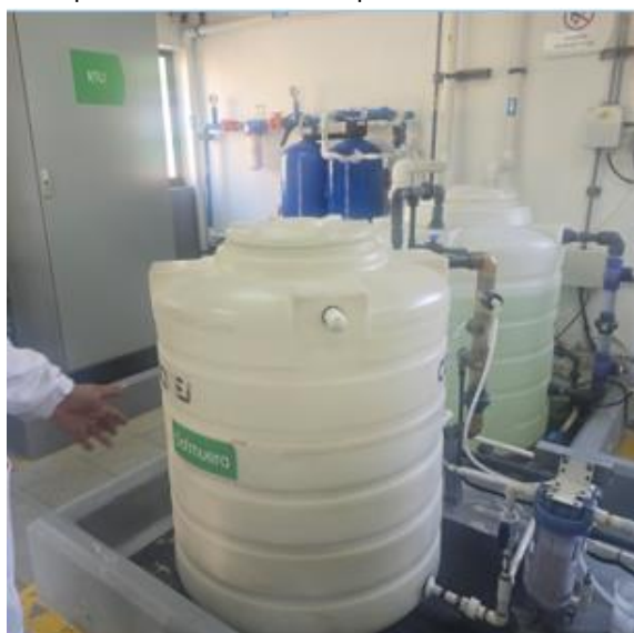
Sistema de preparación de cloro
