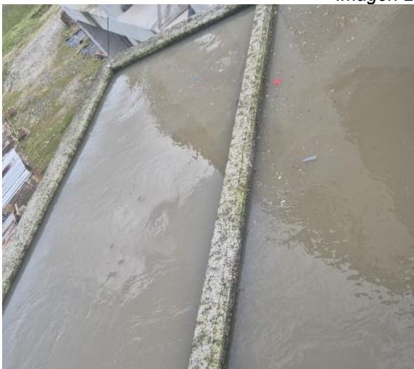
Cámara de entrada
