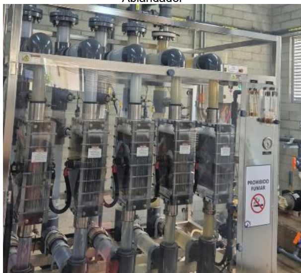
Generador hidrolisis
