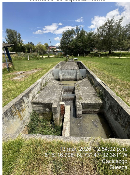
Imagen 6. Vista posterior de la estructura de pretratamiento de la PTAR municipal incluyendo las cámaras de quietamiento
