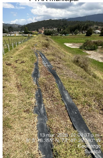
Imagen 8. Remanente de la geomembrana perteneciente a la antigua laguna de oxidación de la PTAR municipal
