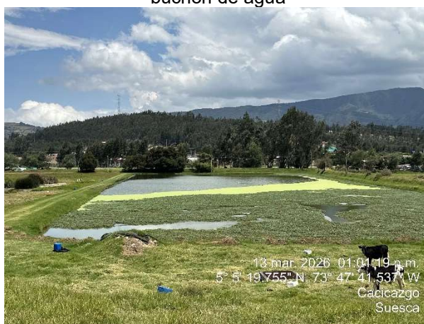
Imagen 10. Laguna de oxidación con presencia de buchón de agua
