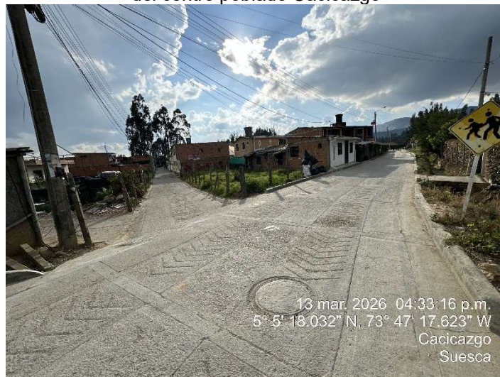
Imagen 1. Pozo de inspección del sistema de alcantarillado del centro poblado Cacicazgo
