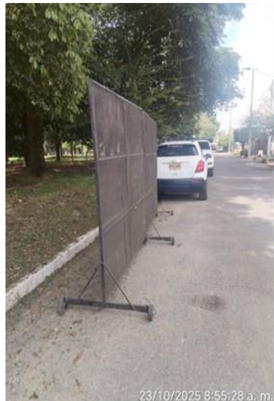
Imagen 88 Malla de protección parque San Jorge
