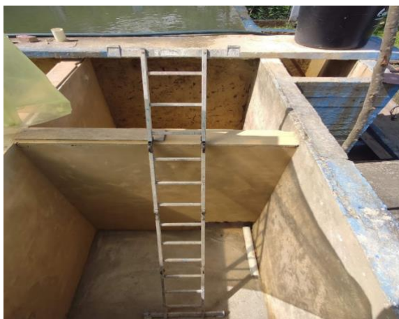
Imagen 15. Mejoramiento de los filtros
