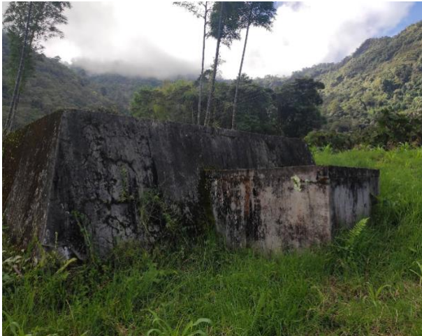
Imagen 21. Vista general del tanque
