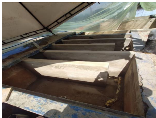
Imagen 14. Obras optimización PTAP
