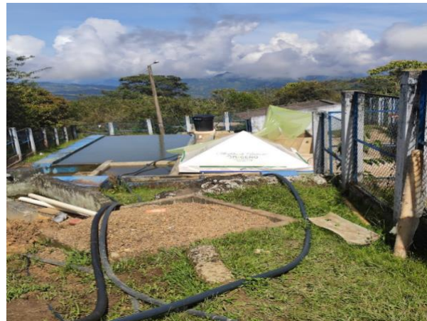
Imagen 12. Vista general de la PTAP
