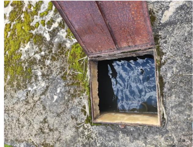
Imagen 22. Tapa ingreso al tanque
