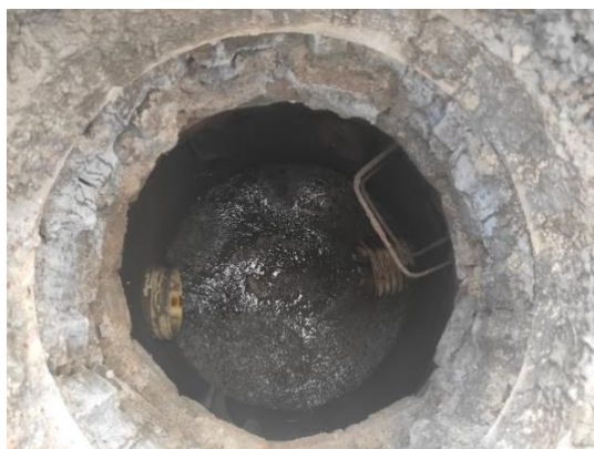
Imagen 31. Vista pozo alcantarillado
