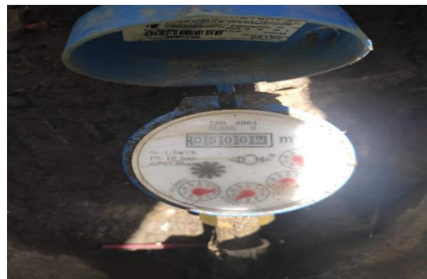
Imagen 28. Detalle de micromedidor
