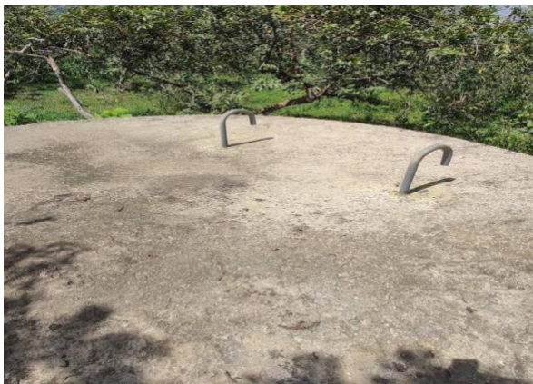
Imagen 23. Vista superior del tanque
