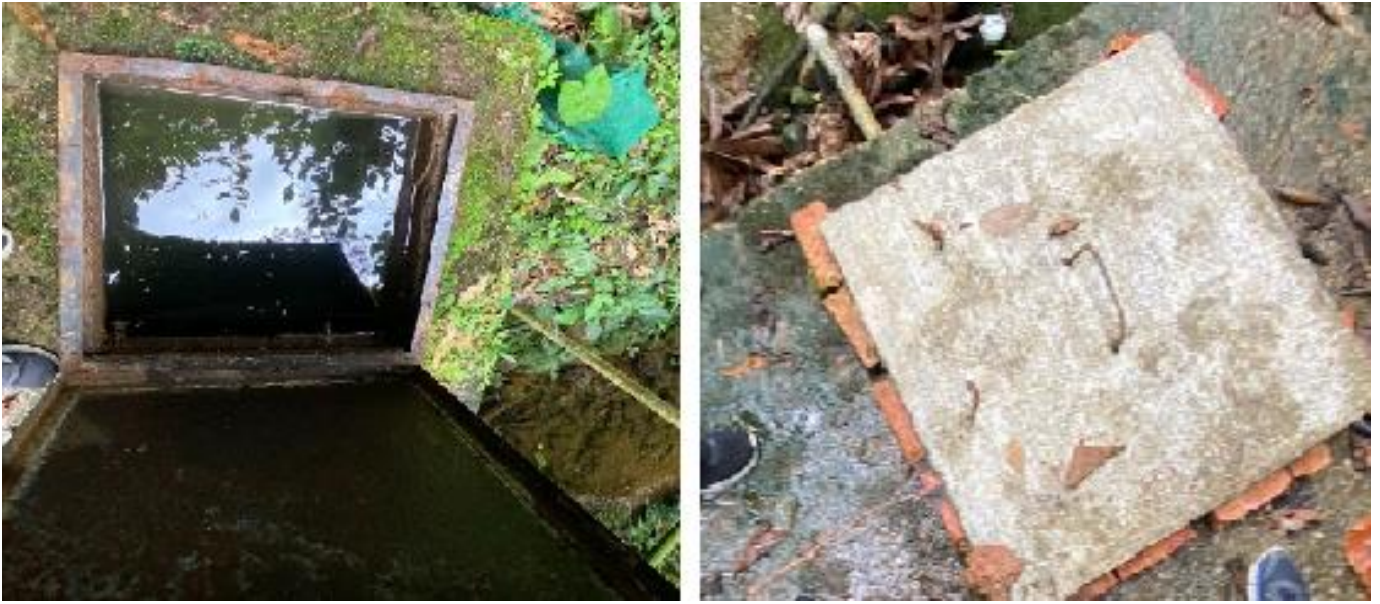
Imagen 2. Tanque de concreto.
