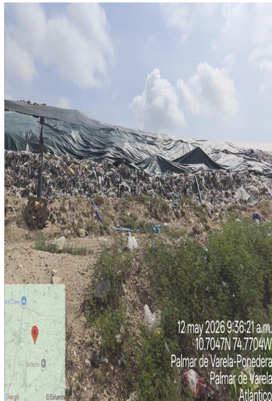
Foto 73 Cobertura de residuos
