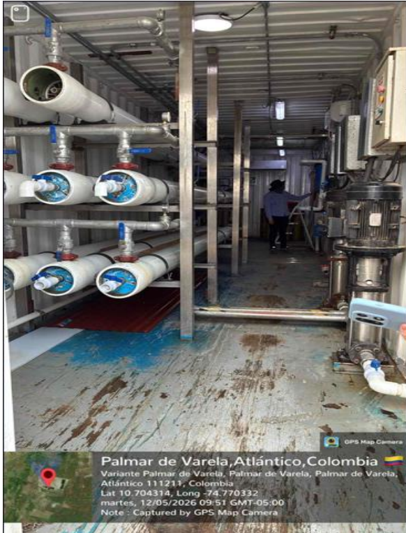
Foto 84 Planta de omosis inversa
