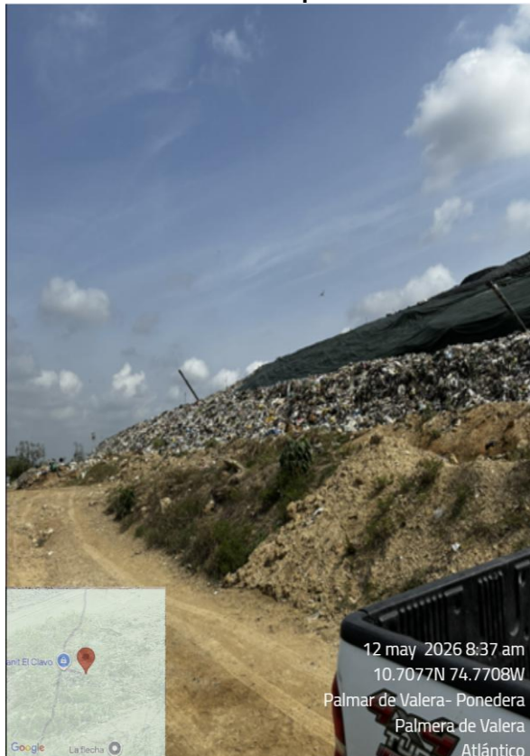
Foto 74 Cobertura de pila de residuos
