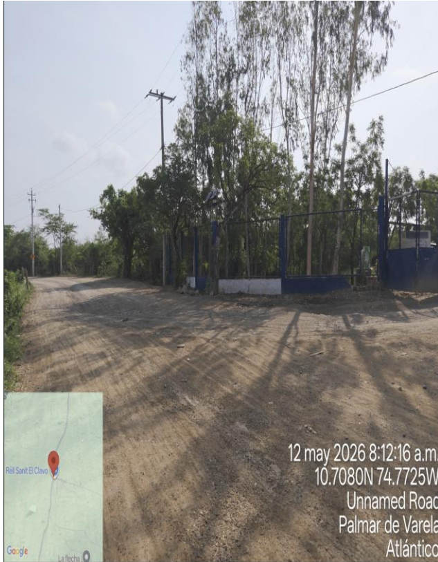
Foto 60 Encerramiento del predio
