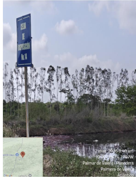
Foto 98 Acumulación de lixiviados celda de disposición No. 14
