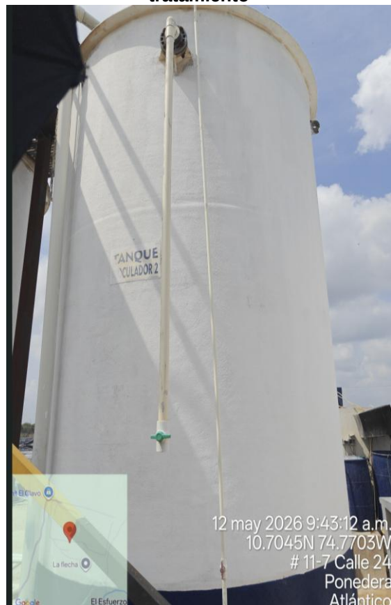
Foto 83 Tanque floculador de la planta de tratamiento
