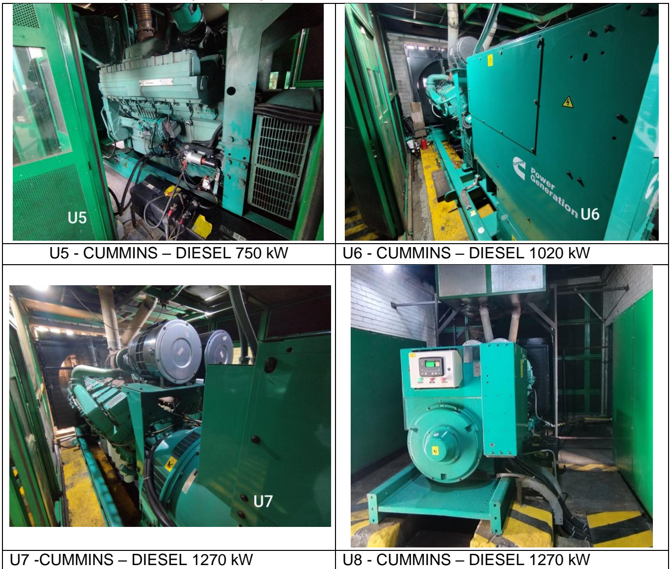
Figura 5. Registro Fotográfico PCH – Mitú (fuera de servicio) - GENSA
