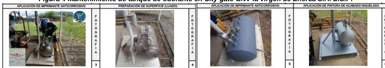
Figura 4 Mantenimiento de tanque de odorante en City gate GNV la virgen de Enerca S.A. E.S.P.
