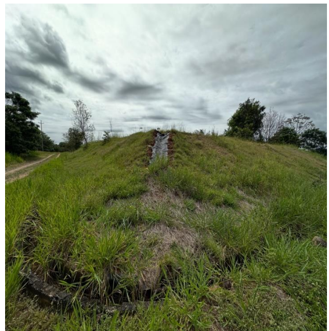
Foto 106. Canal de escorrentía geomembrana zona clausurada
