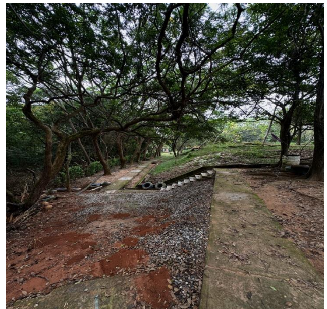
Foto 110. Canal perimetral concreto sector clausurado Macondo
