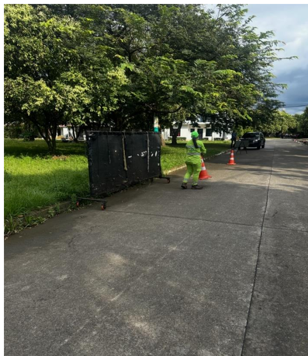
Foto 84. Malla de protección y operaria ayudante – señalización. Sector Cll 29ª Cra 10 Hora: 7:2
