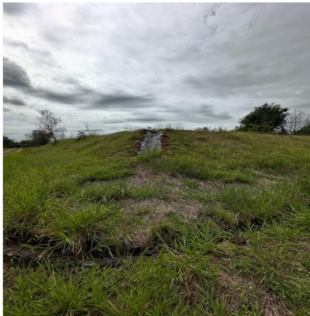
Foto 105. Canal de escorrentía geomembrana zona clausurada
