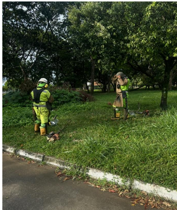
Foto 86. Cuadrillas corte – señalización. Sector CII 29ª Cra 10 Hora: 7:29
