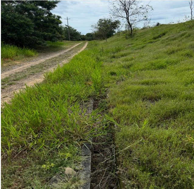
Foto 105. Canal de escorrentía geomembrana zona clausurada
