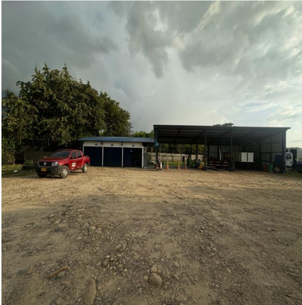
Foto 15. Zona mantenimientos menores y almacén
