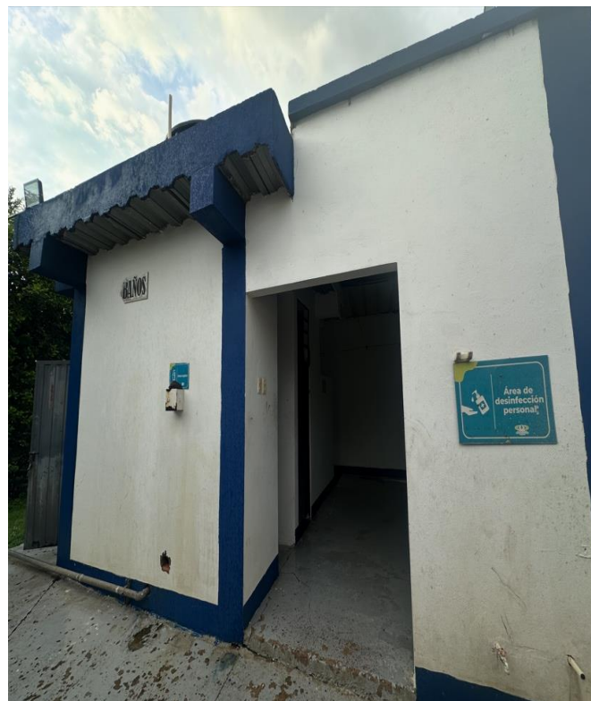
Foto 20. Instalaciones sanitarias base de operaciones
