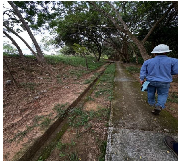
Foto 110. Canal perimetral concreto sector clausurado Macondo
