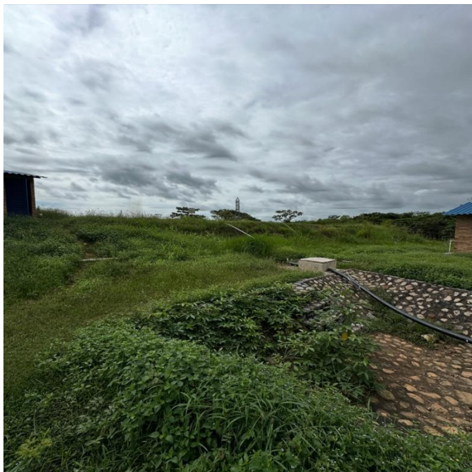
Foto 117. Caja de inspección entrada de lixiviados a reactor
