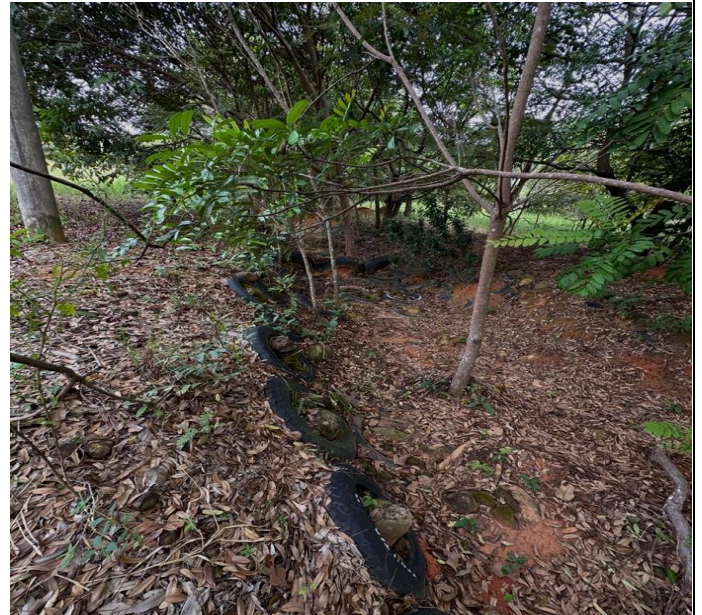
Foto 102. Canal perimetral manejo aguas lluvias y de escorrentía
