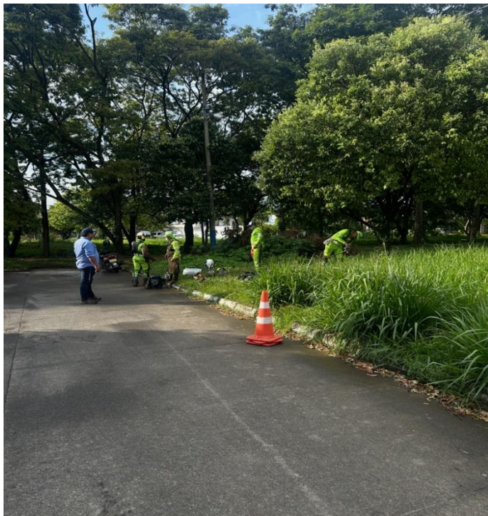
Foto 85. Cuadrillas corte – señalización. Sector CII 29ª Cra 10 Hora: 7:25
