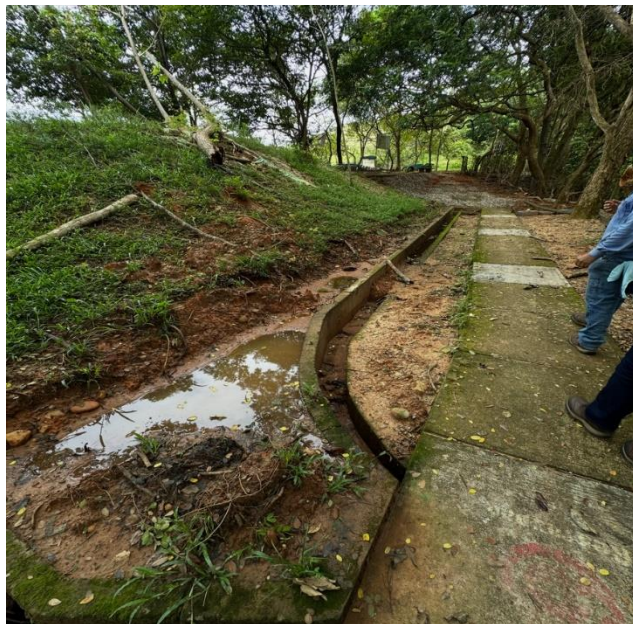
Foto 109. Canal perimetral concreto sector clausurado Macondo
