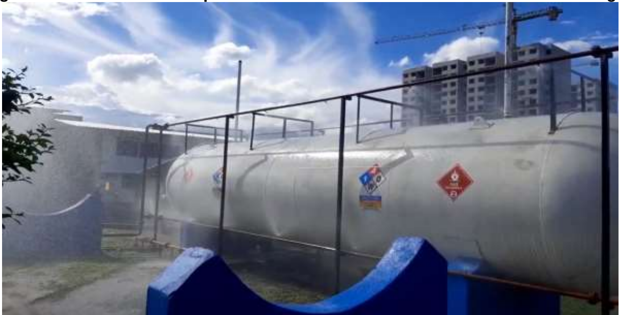
Figura 10: Prueba RCI en la planta de envasado de ENVAGAS S.A. E.S.P. en Ibagué
