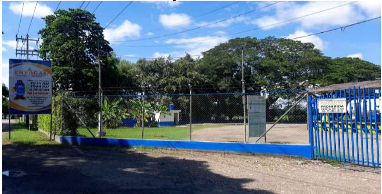
Figura 5: Fotografía instalación física Planta de envasado de ENVAGAS S.A. E.S.P. en Puerto Salgar, Cundinamarca
