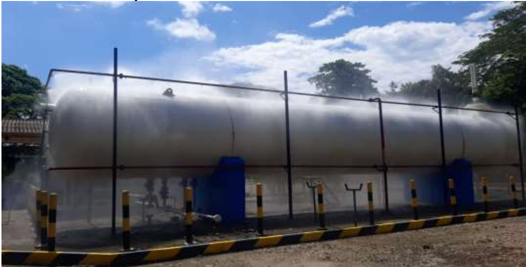
Figura 9: Prueba RCI en la planta de envasado de ENVAGAS S.A. E.S.P. en Puerto Salgar
