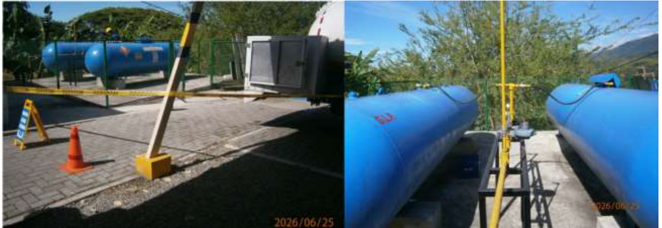
Figura 15. Inspección Tanques estacionarios "Mercacentro No. 10" en Ibagué
