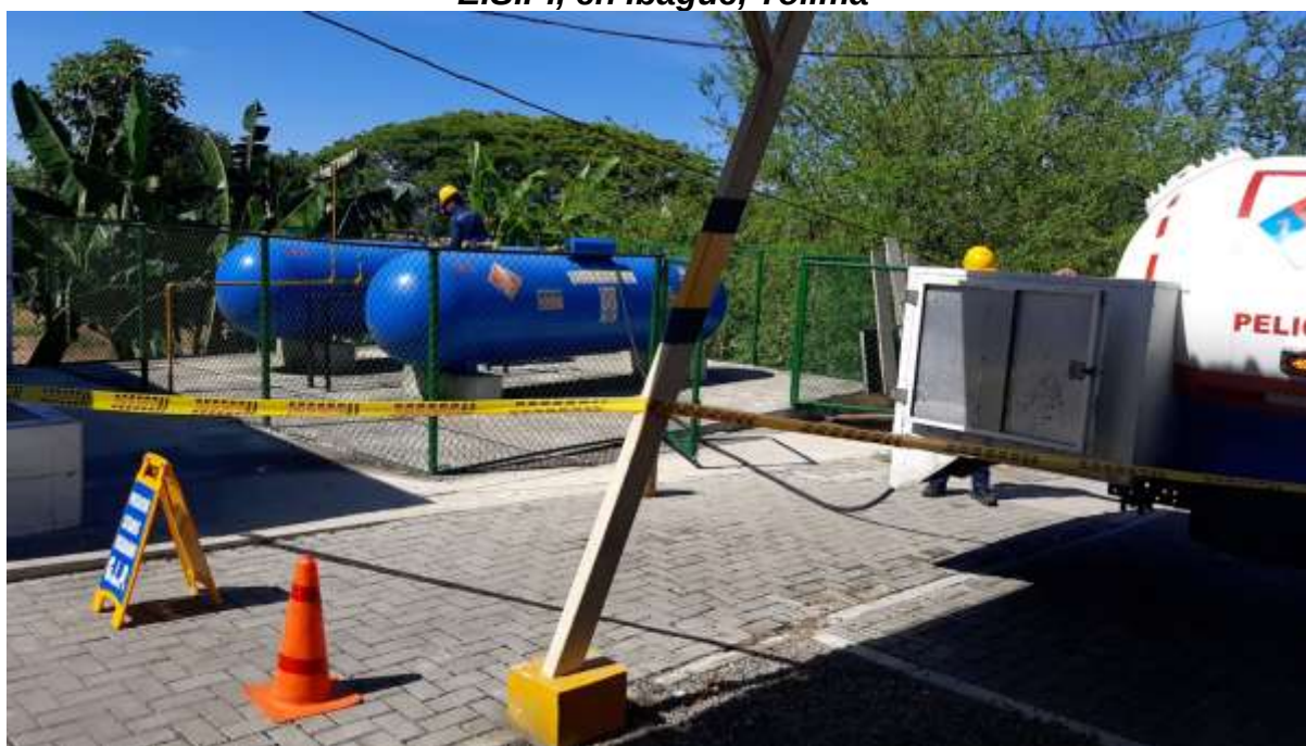
Figura 7: Tanques estacionarios de Mercacentro No 10, atendidos por ENVAGAS S.A. E.S.P., en Ibagué, Tolima
