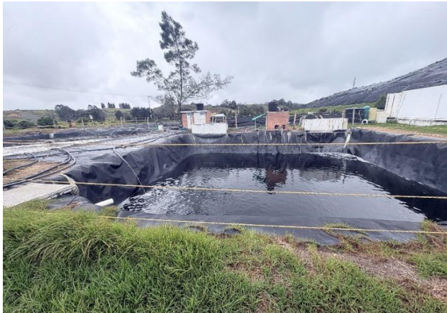
Foto 41. Piscina de almacenamiento de lixiviado tratado
