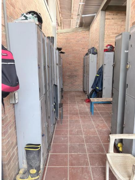
Foto 19. Zona de vestier
