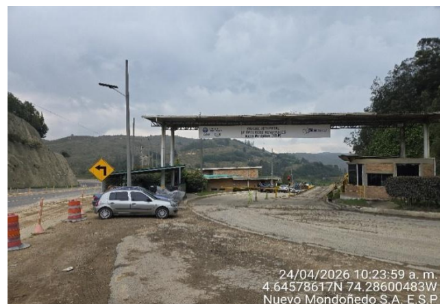
Foto 12. Caseta de vigilancia
