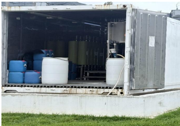
Foto 39. Módulo ósmosis inversa - Tratamiento por membranas
