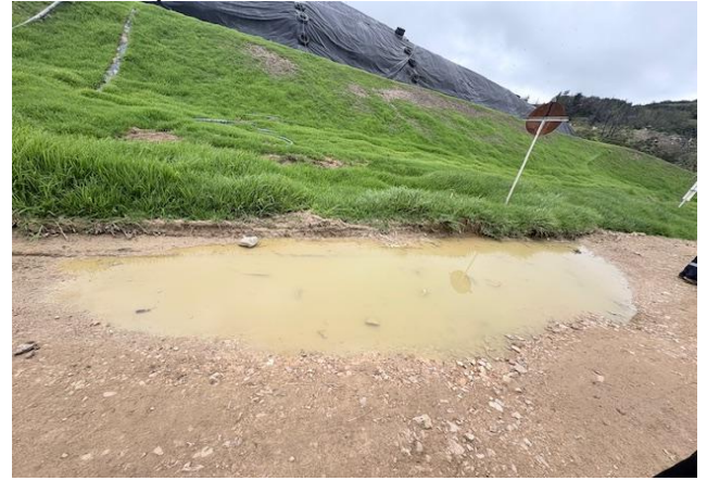
Foto 4. Empozamiento de agua en la vía que conduce a la planta de tratamiento de lixiviados
