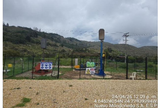
Foto 6. Cerramiento perimetral en alambre de púas
