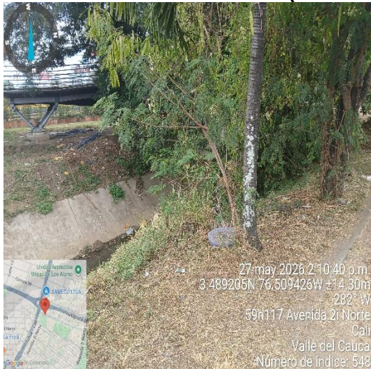
Foto 52. Punto Crítico Álamos (Avenida 2 Norte)
