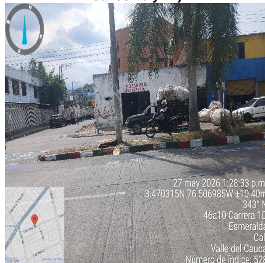
Foto 55. Punto Crítico Manzanares (Carrera 1D entre Calles 46 y 47)
