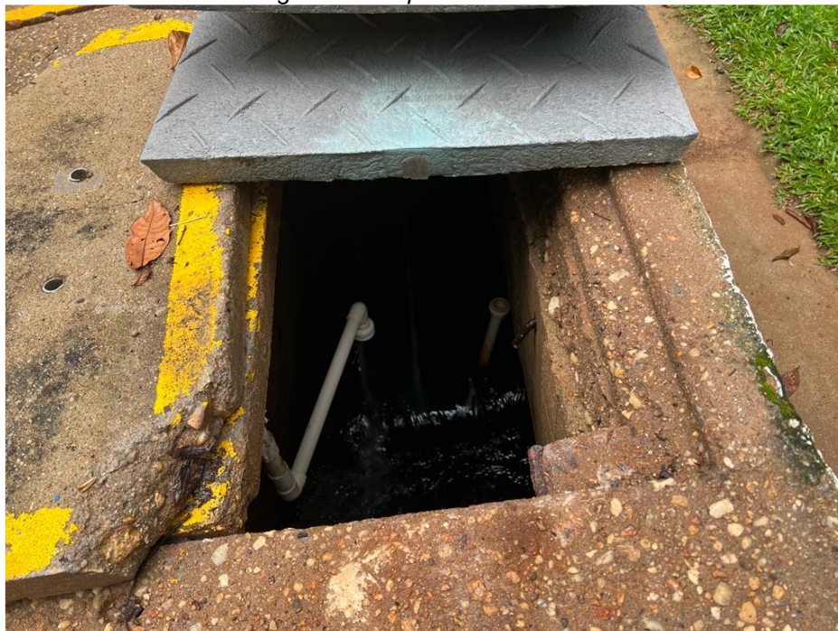
Imagen 24 Tanque de desinfección
