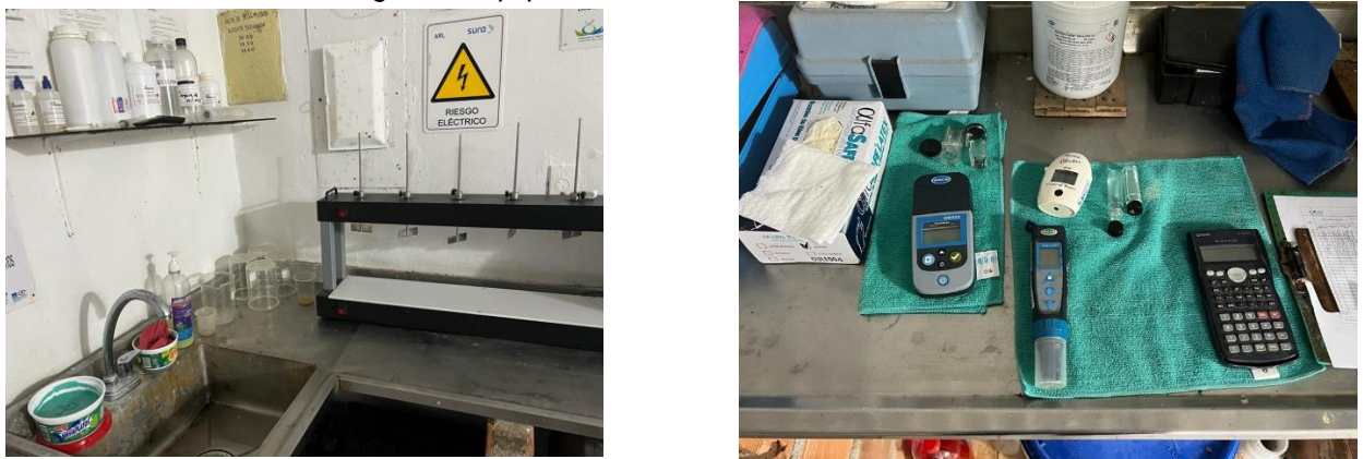
Imagen 32 Equipos de laboratorio PTAP El Cristo
