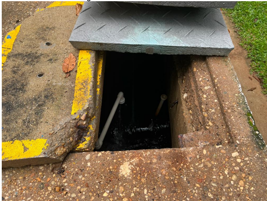
Imagen 20 Sistema de desinfección
