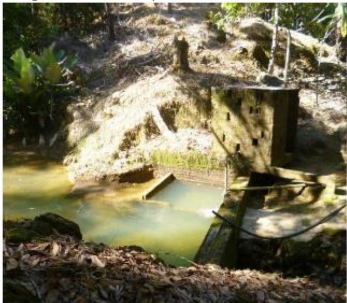
Imagen 7 Sistema de captación Quebrada La Primavera
