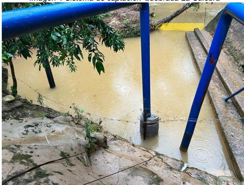
Imagen 4 Sistema de captación Quebrada La Culebra
