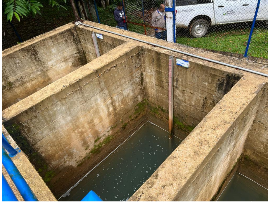
Imagen 23 Unidades de Filtración
