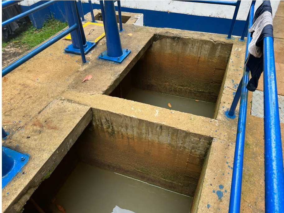
Imagen 19 Unidades de Filtración
