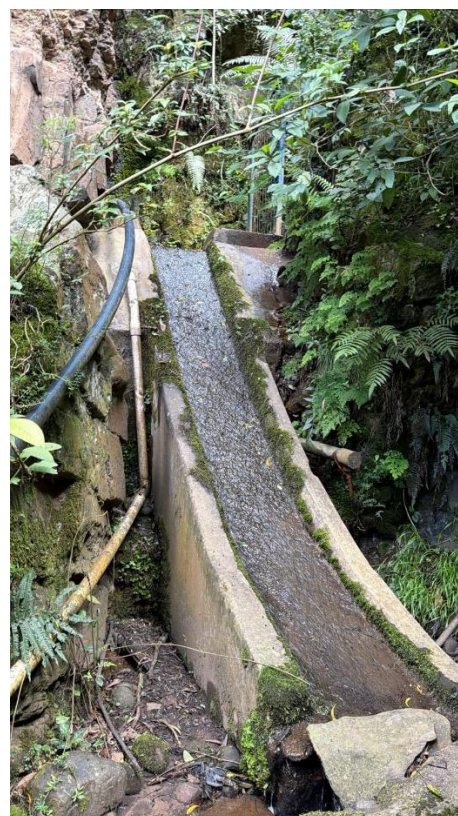
Estructura de ingreso captación El Cisque o Chircal. Fuente: Registro fotográfico de la visita SSPD, mayo de 2026.
