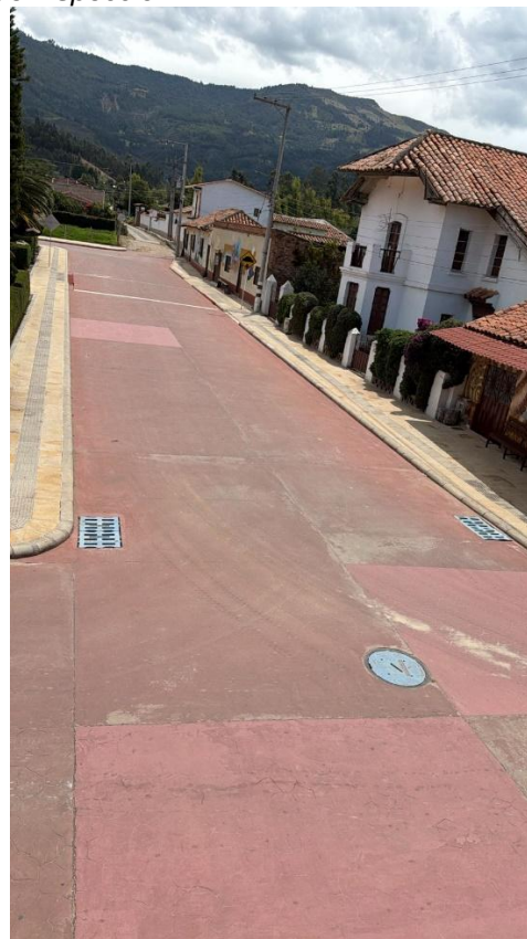
Imagen 8 Sumideros y pozos de inspección.
