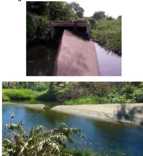
Imagen 21. Emisario final colector calle 21
