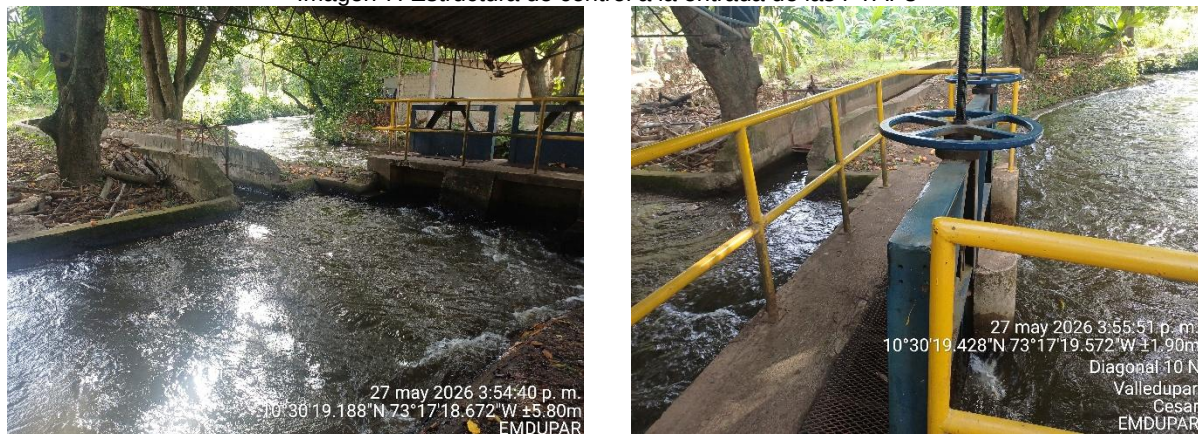
Imagen 7. Estructura de control a la entrada de las PTAPs
