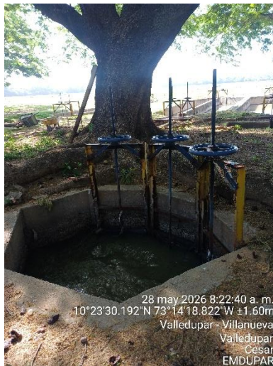
Imagen 29. Compuertas en cámara de distribución
