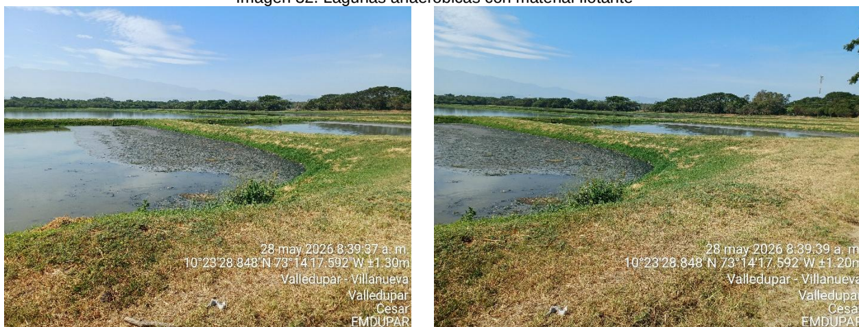
Imagen 32. Lagunas anaeróbicas con material flotante
