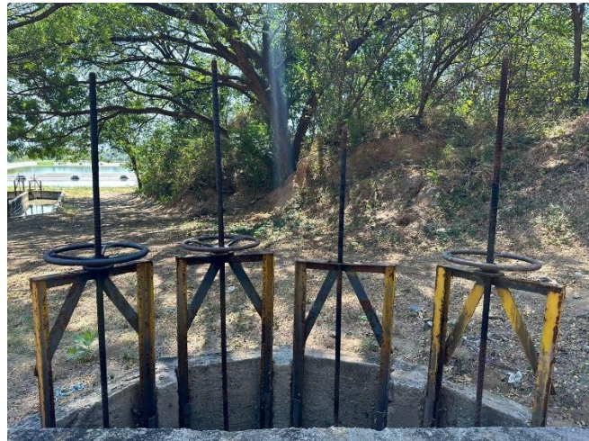
Imagen 29. Compuertas en cámara de distribución
