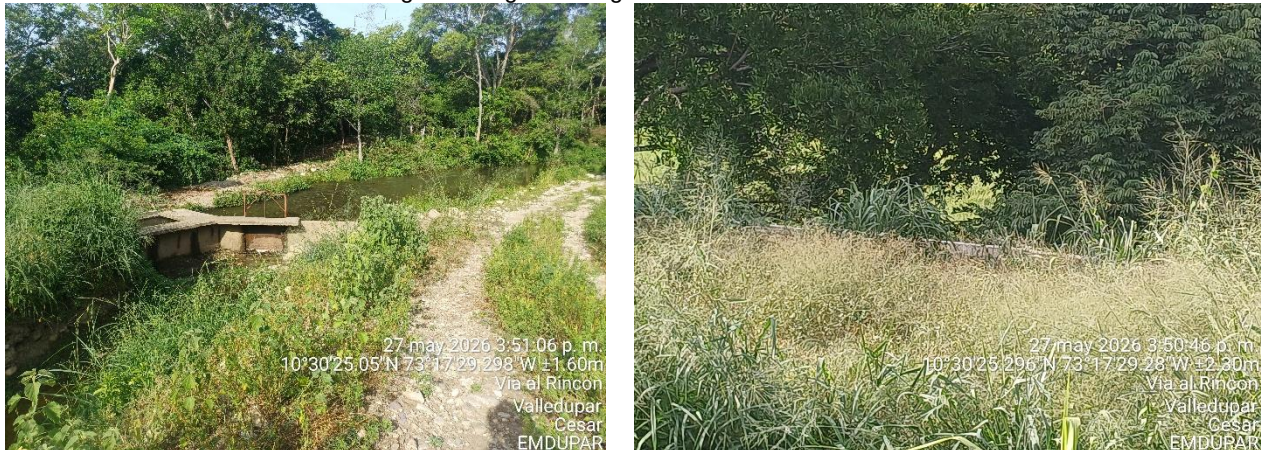
Imagen 6. Registro fotográfico canales de aducción
