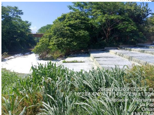
Vertimiento desde planta de aireación
