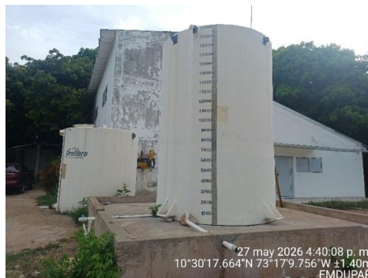
Imagen 15. Tanques de almacenamiento de productos químicos, área de almacenamiento y dosificación de cloro gaseoso
