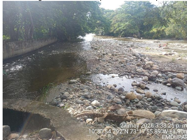
Imagen 4. Fuente de captación Río Guatapurí
