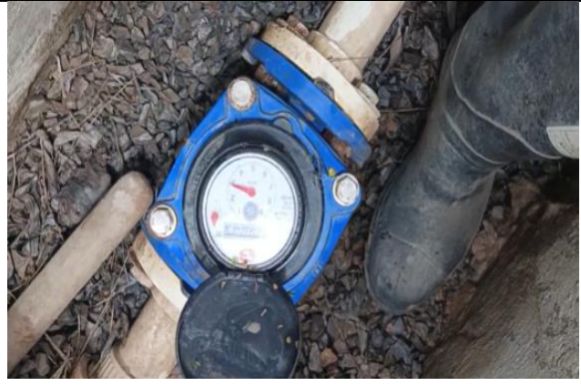
Imagen 27. Macromedidores de salida
