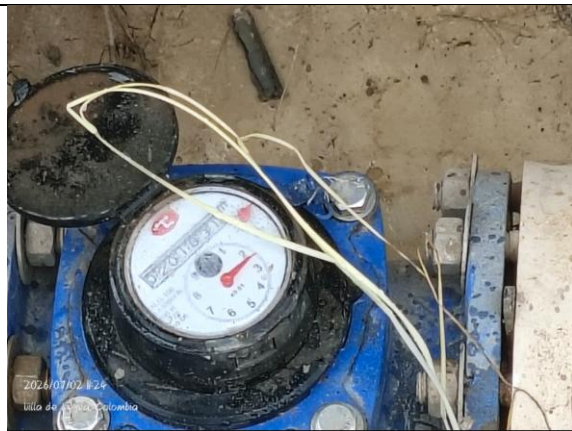
Imagen 27. Macromedidores de salida
