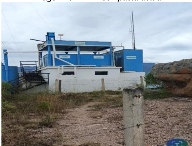
Imagen 13. PTAP compacta actual
