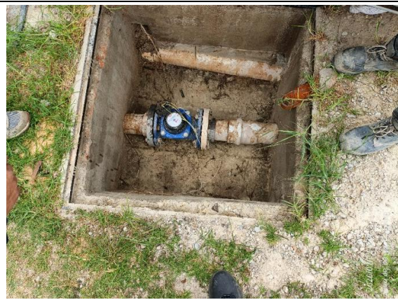
Imagen 27. Macromedidores de salida
