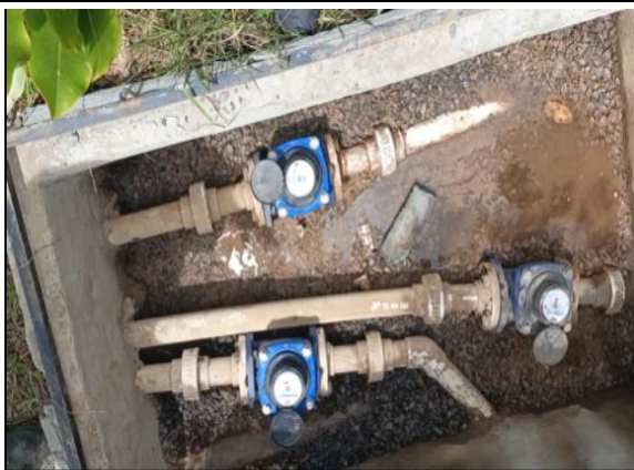
Imagen 27. Macromedidores de salida
