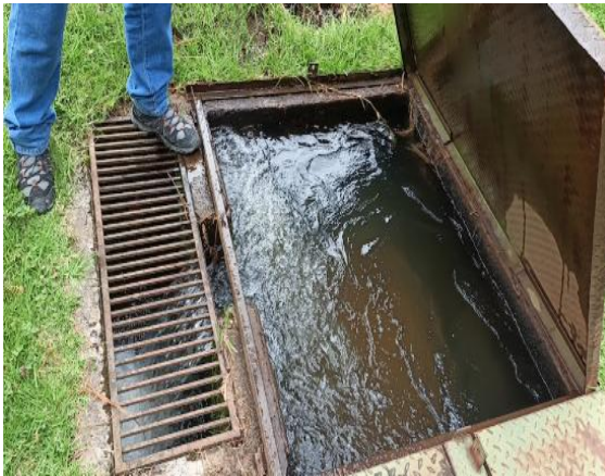
Imagen 9. Cámara de entrada al desarenador
