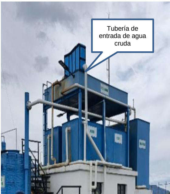
Imagen 15. Mezcla rápida
