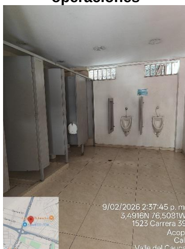
Foto 22. Servicios sanitarios base de operaciones
