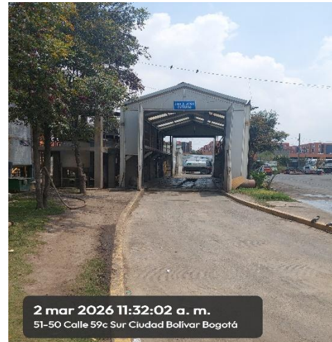
Foto 8 Zona de lavado de vehículos
