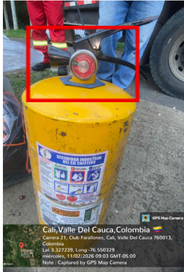
Foto 45. vehículo LFL257 Foto extintor con sobrecarga
