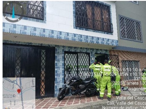
Foto 54. Vista fachada cuartelillo de barrido ubicada en el barrio Valle de Lili
